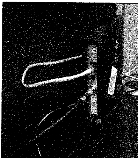
Imagen 13. Conexión Ethernet, coaxial y DC. Fuente: ICC, Laboratorio de REPAIR
