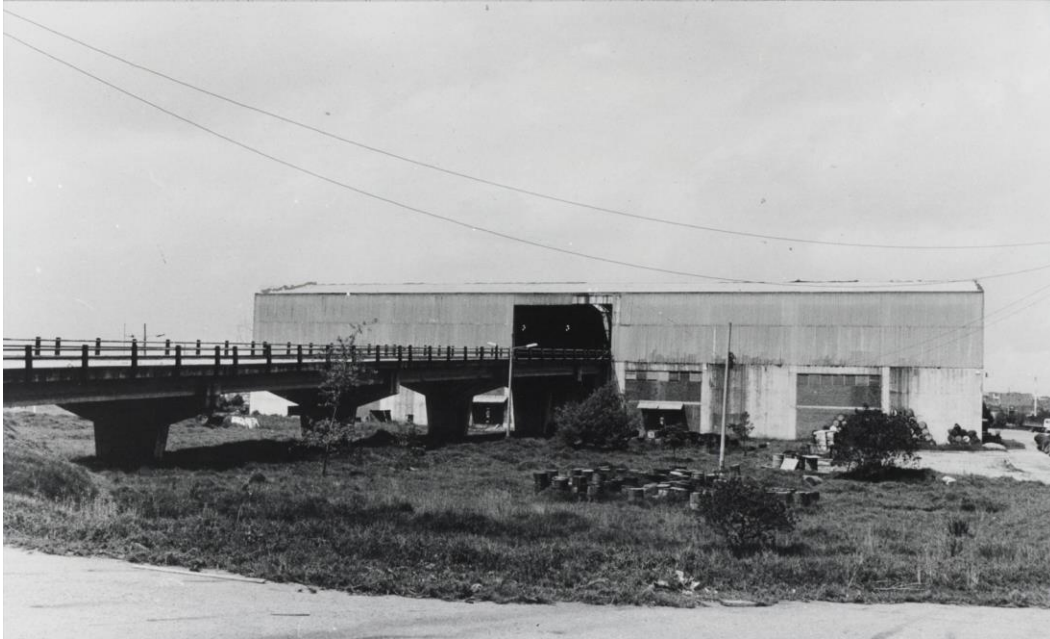
Figura 35. Foto antiguo edificio
