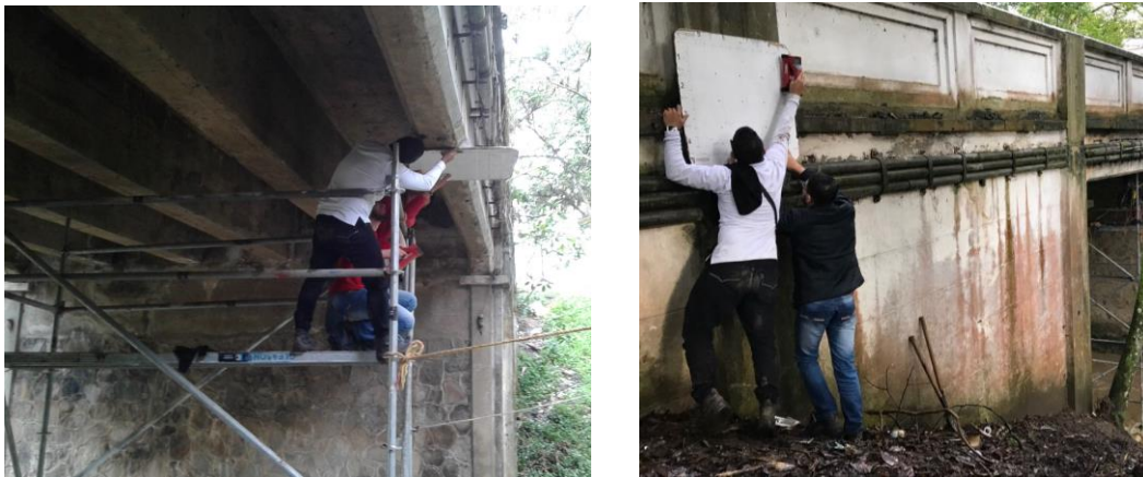
Imagen 14: Lectura del acero de refuerzo de la estructura
