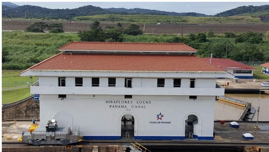
Ilustración 15. Casa administrativa del canal de Panamá.
