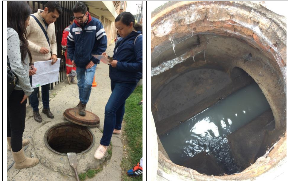
Figura 9. Verificación catastro red de alcantarillado distrito Santa Inés (Autor).
