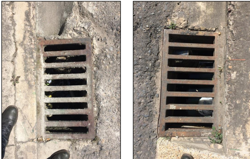
Figura 15. Sumideros Alcantarillado combinado existente. (Autor).
