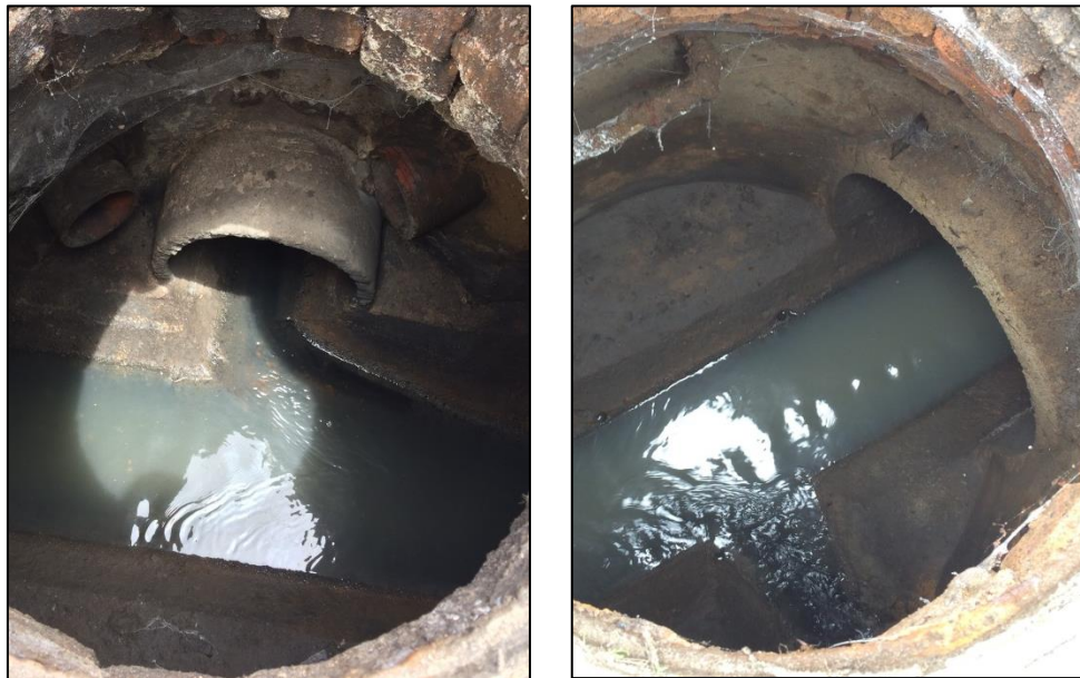
Figura 13. Tuberías Alcantarillado combinado existente. (Autor.)
