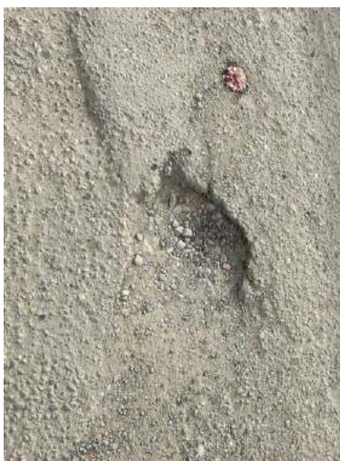
Ilustración 16. Descascaramiento (DC). Fuente: Propia
