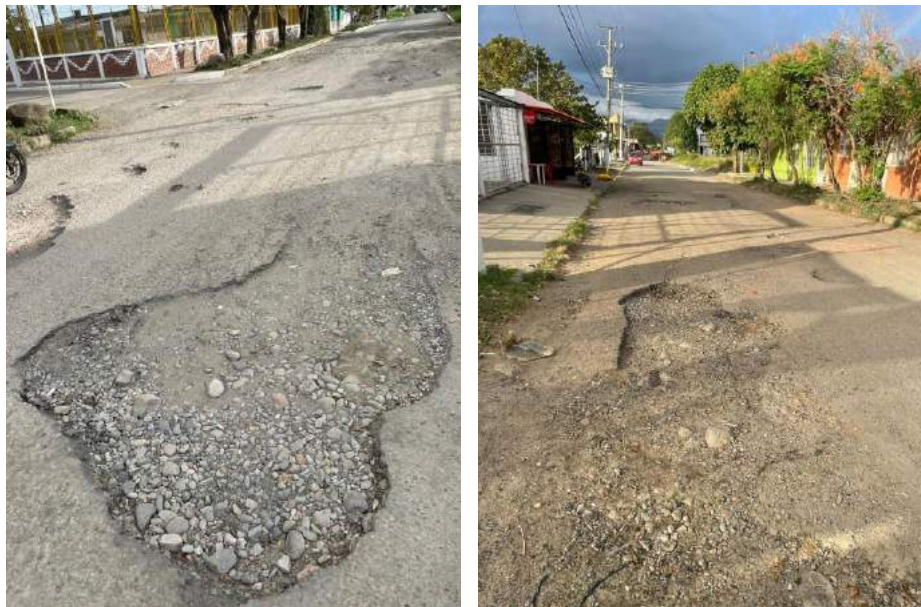
Ilustración 17. Baches (BCH). Fuente: Propia
