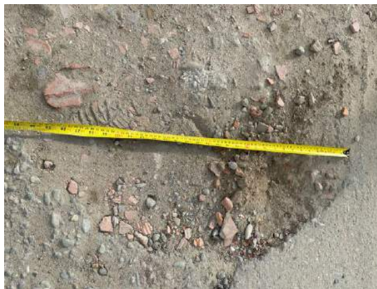
Ilustración 7. Medición de longitud huecos. Fuente: Propia.
