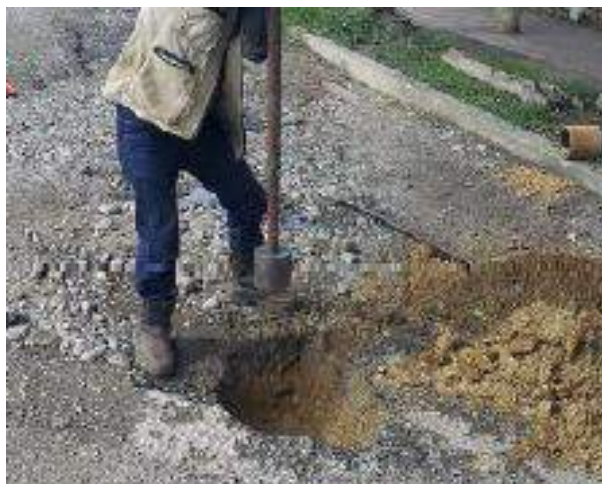
Ilustración 31. Apique realizado en la vía carrera 14. Fuente: Laboratorio NHSQ SAS
