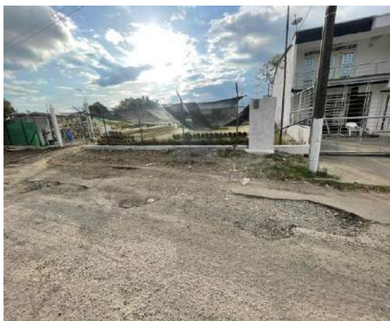
Ilustración 19. Presencia de baches y huecos. Fuente: Propia
