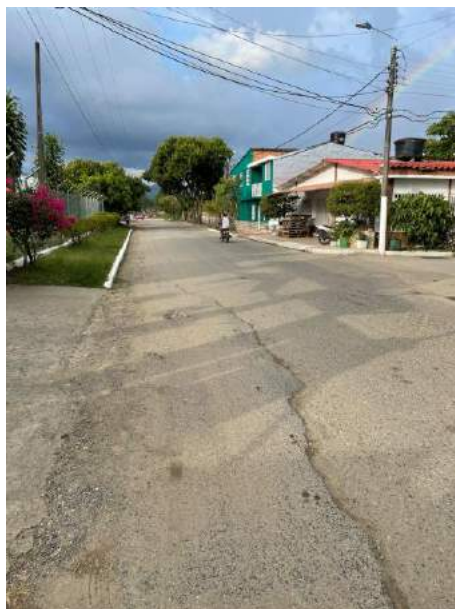
Ilustración 15. Abultamiento (AB). Fuente: Propia
