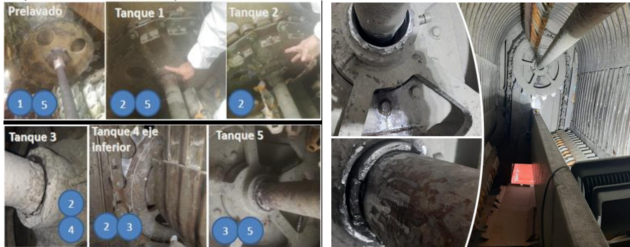
Figura 10. Intervención del sistema de transmisión interno de lavadora de botellas (antes y después de la intervención)
