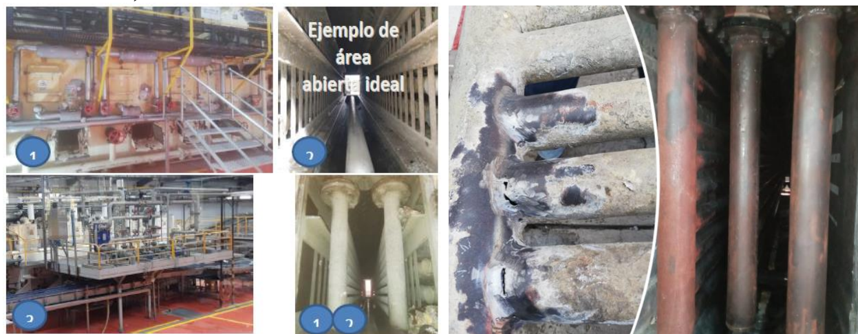
Figura 7. Intervención del sistema de calentamiento en lavadora de botellas (antes y después de la intervención)
