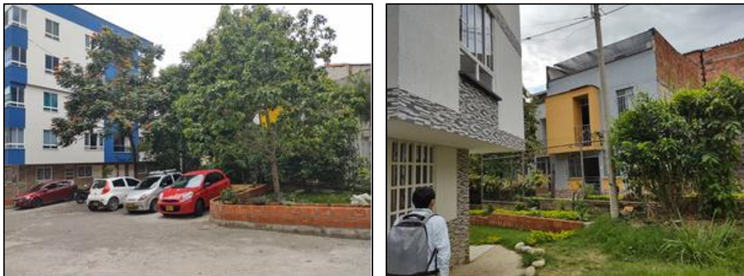
Figura 16. Conjunto residencial portal de Santillana
