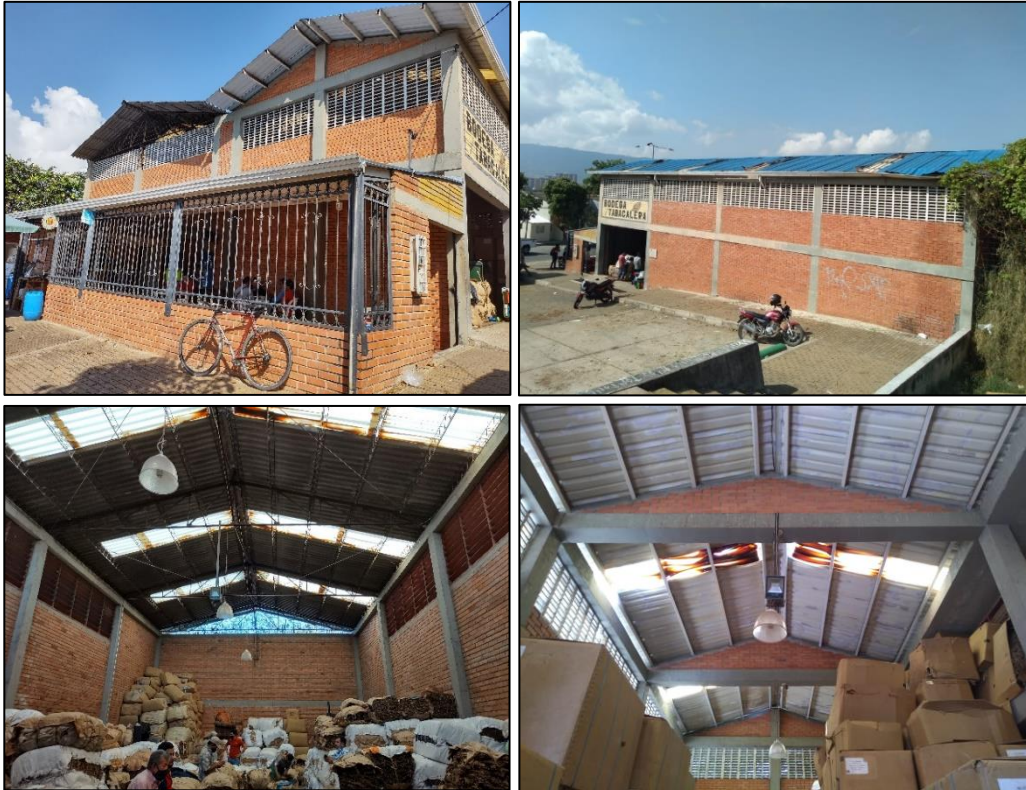
Figura 4. Registro fotográfico durante la inspección visual bodega tabacalera
