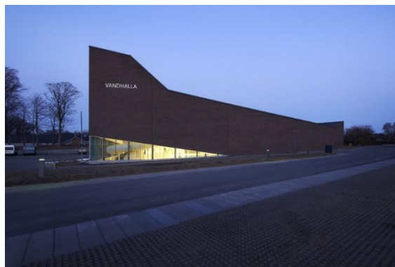
Figura 7. Centro de Rehabilitación Vandhalla.
