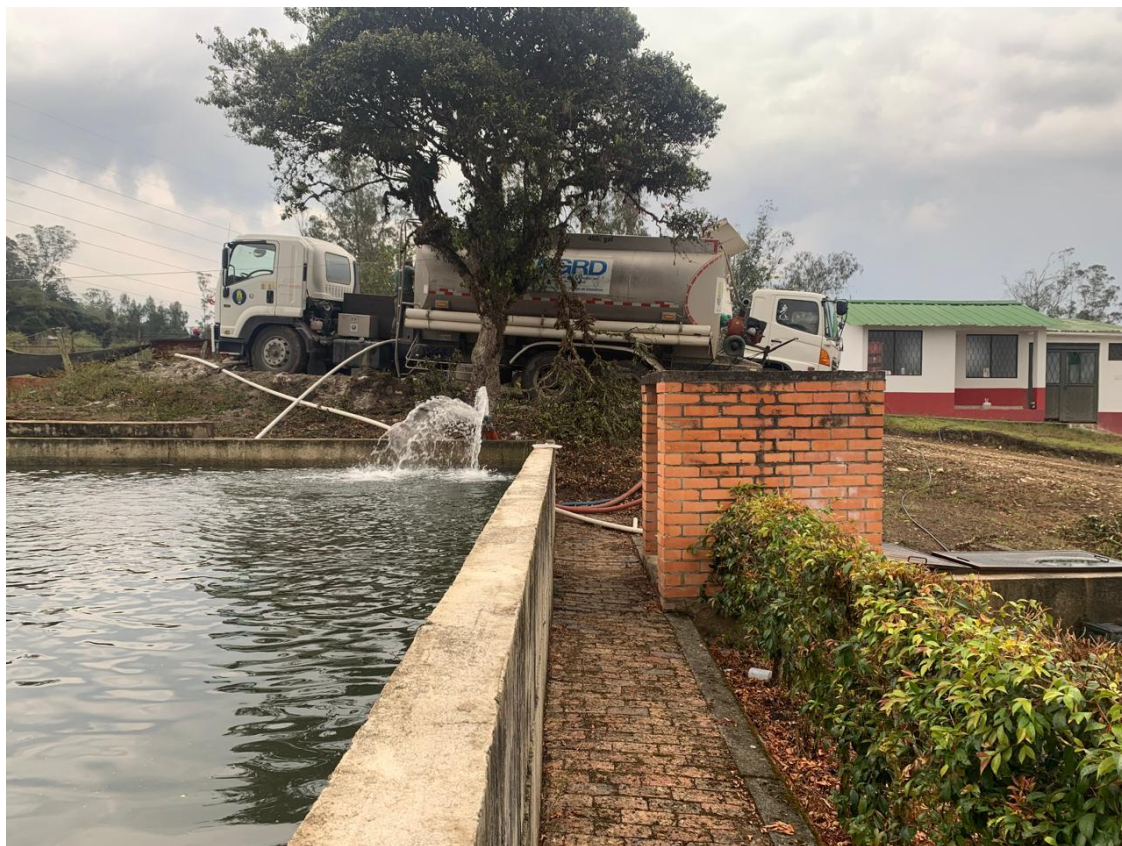
Figura 26: Gestión operativa para el abastecimiento por medio de carrotanques a la planta de tratamiento de agua potable
