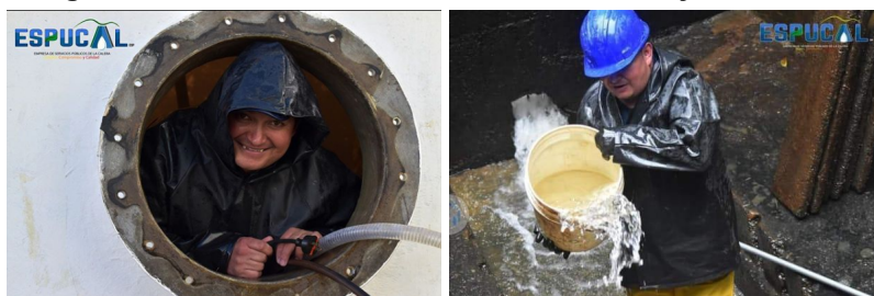
Imagen 8. Mantenimiento de redes de aducción y conducción.
