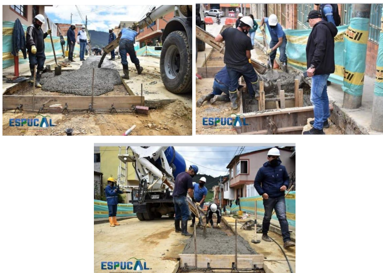
Imagen 9. Supervisión de obra.
