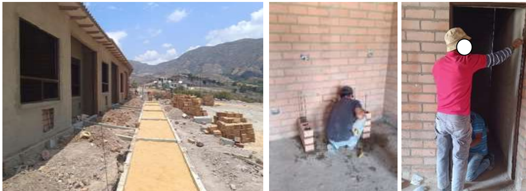
Figura 8. Apoyo técnico en supervisión de viviendas VIP San Nicolas.
