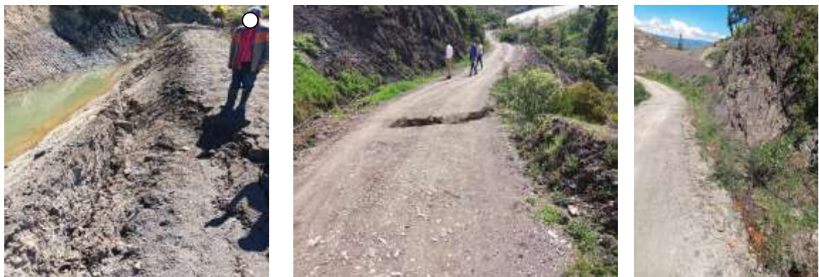
Figura 9. Prevención de deslizamiento y detección de la falla en vía quebrada arriba.
