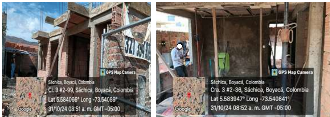
Figura 5. Visita de control urbano vivienda número 1.
