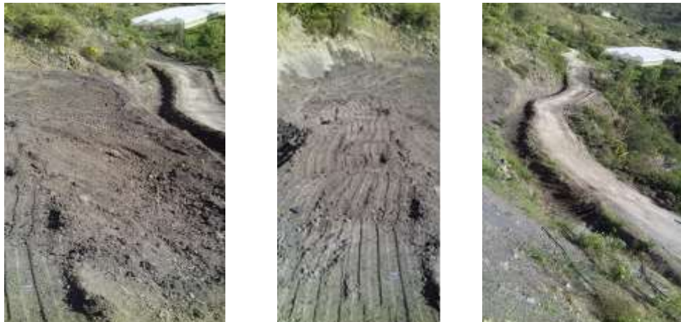
Figura 10. sellamiento total del reservorio que causo la filtración de agua.
