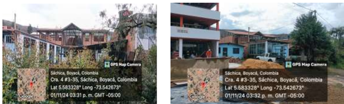
Figura 7. Visita de control urbano vivienda número 3.
