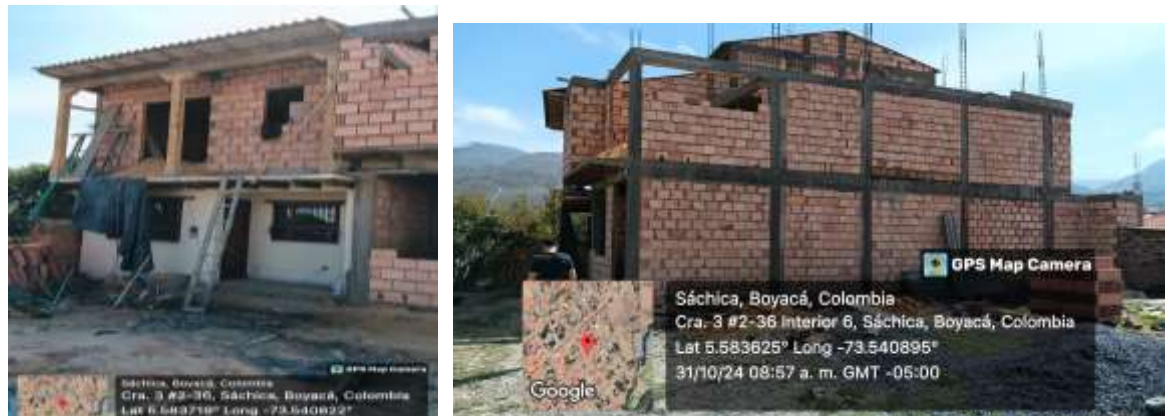
Figura 6. Visita de control urbano vivienda número 2.
