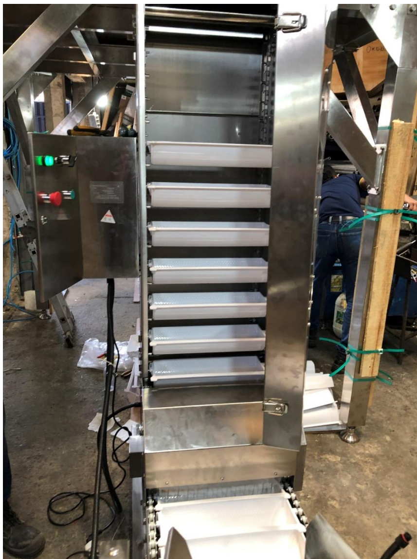
Figura 18. Montaje de cangilones en el elevador.
