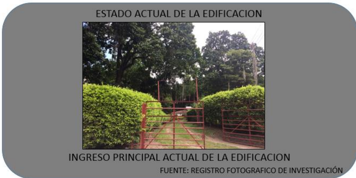
Figura 53. Estado actual de la edificación
