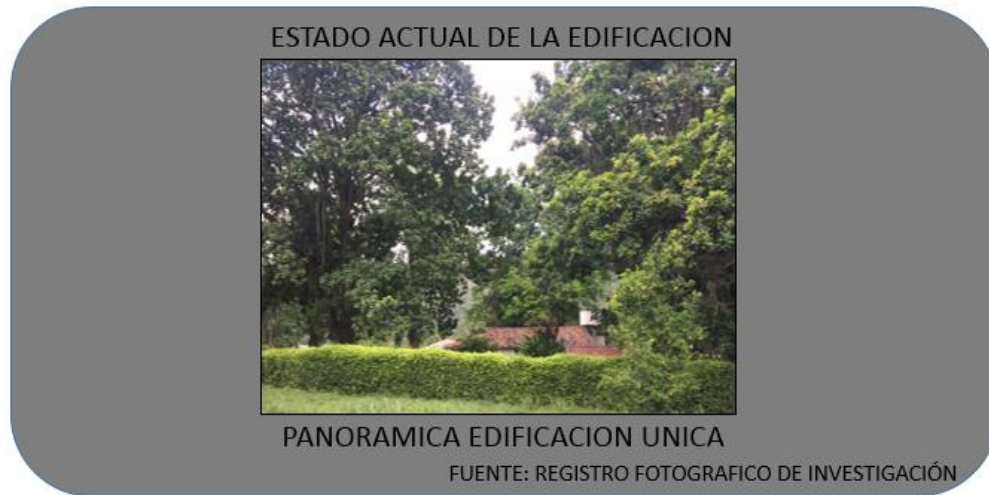
Figura 52. Estado actual de la edificación
