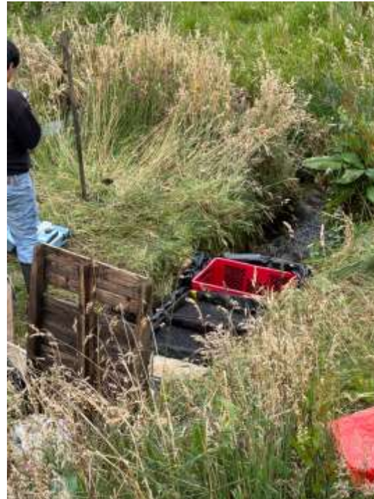
Nivelación del Canal
