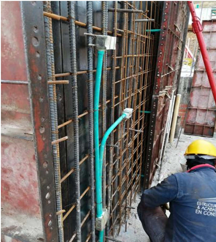
Ilustración 7 Armado de formaleta metálica para muro pantalla.
