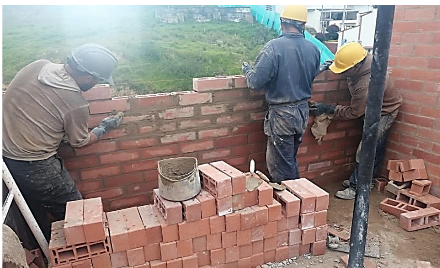
Ilustración 9 Pega de mampostería piso 5 con limpieza y emboquille.
