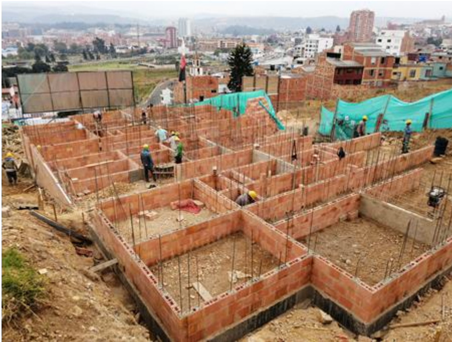
Ilustración 3 Sistema mampostería estructural.
