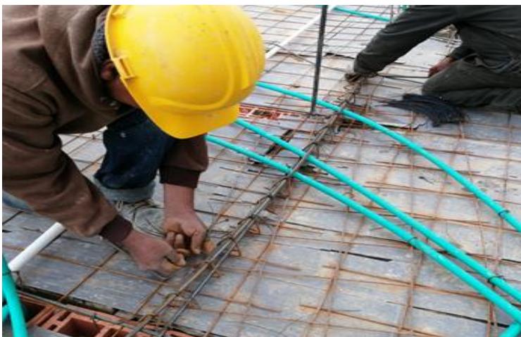
Ilustración 4 Amarre de acero de placa de entrepiso y contra piso.
