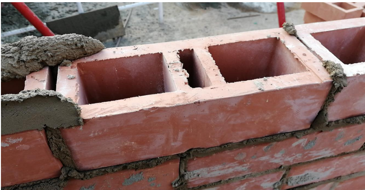
Ilustración 10 Junta de pega (1 cm) para mampostería estructural
