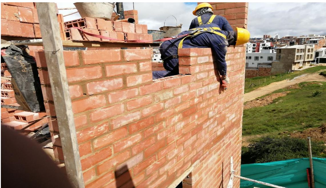
Ilustración 11 Construcción de mampostería estructural
