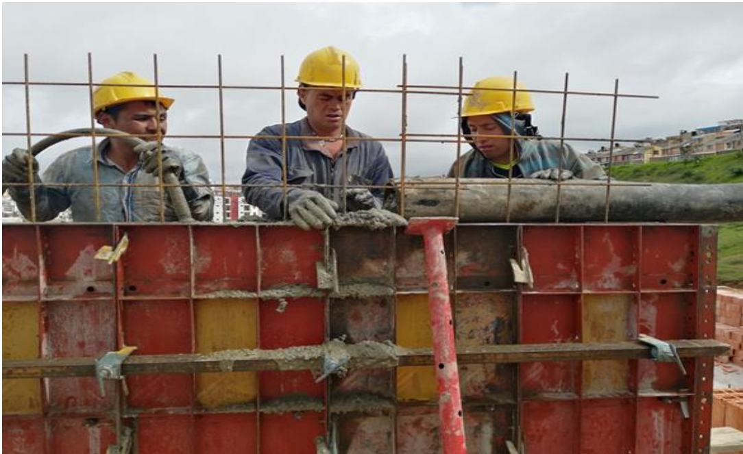
Ilustración 8 Vaciado de concreto en muro pantallas de hormigón
