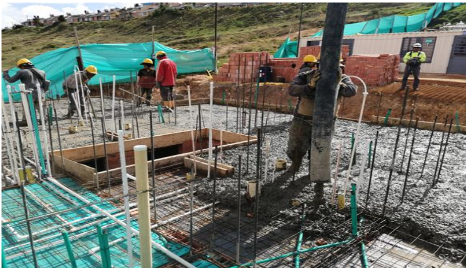
Ilustración 5 Vaciado de concreto en la placa de entrepiso.
