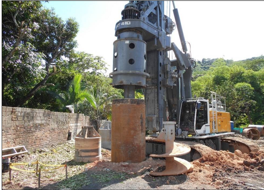
Figura 37: Pilotaje Eje 4. Fuente: Constructora Colpatría
