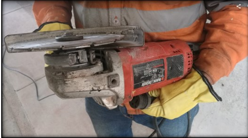
Figura 33: Profundización y ruteo de fisura con cuchilla de diamante. Fuente: Constructora Colpatría
