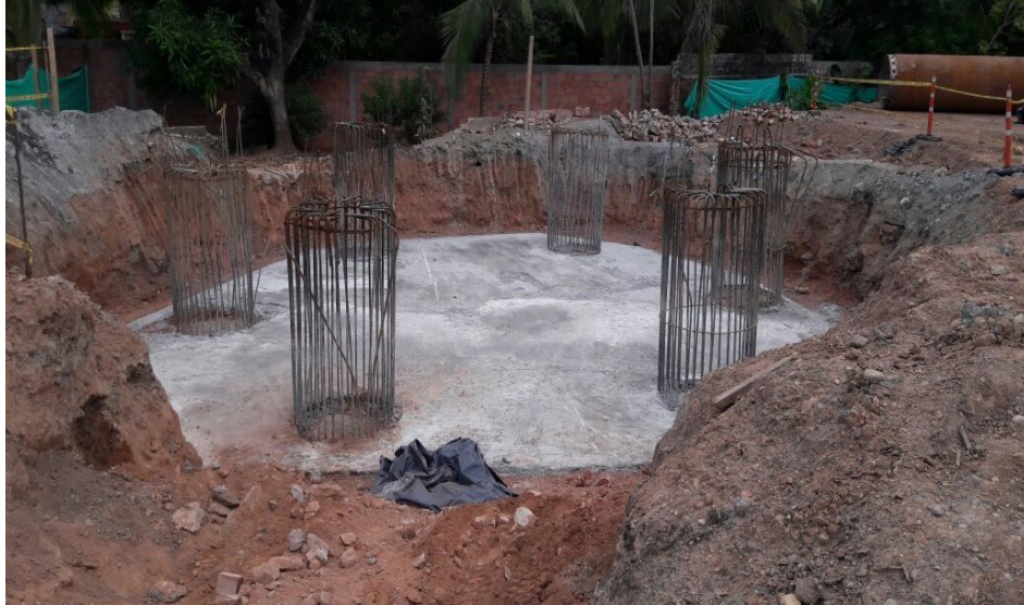
Figura 39: Solado cimentación Eje 4. Fuente: Constructora Colpatria
