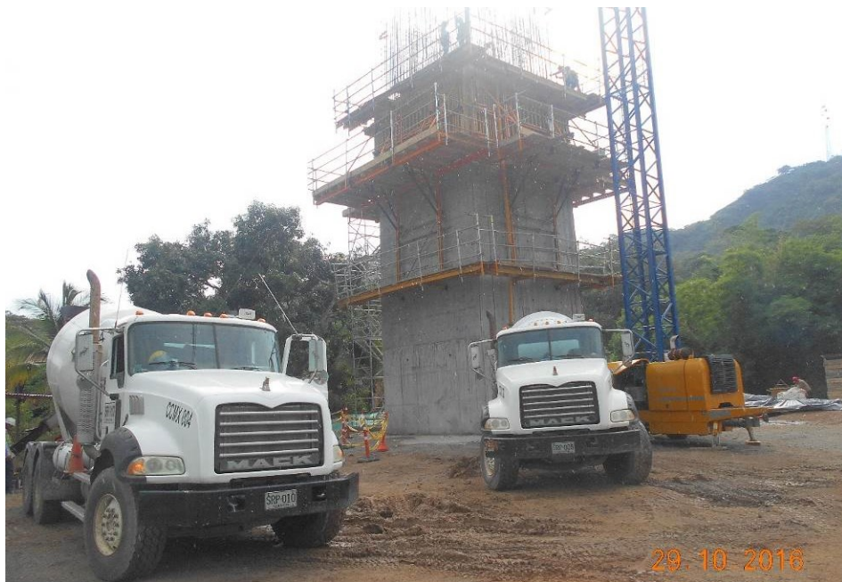
Figura 44: Descarga de concreto. Fuente: Constructora Colpatría
