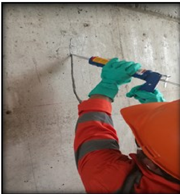
Figura 35: Colocación del material de sello. Fuente: Constructora Colpatria
