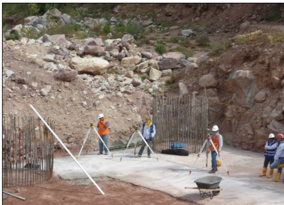
Figura 18: Replanteo topográfico placa concreto de limpieza. Fuente: Constructora Colpatría
