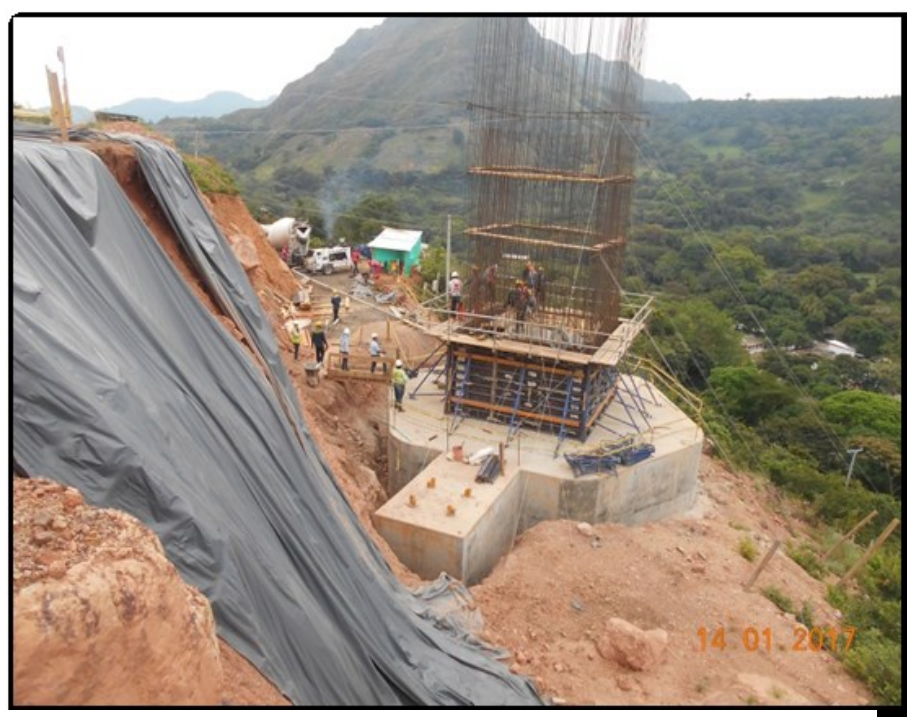
Figura 22: Armado de acero pila. Fuente: Constructora Colpatría
