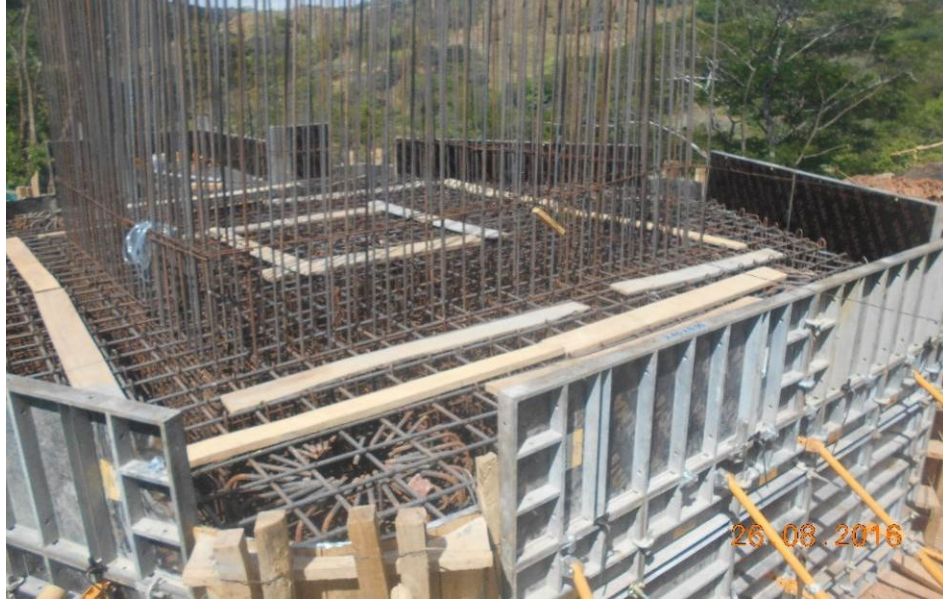
Figura 41: Armado de zapata Eje 4. Fuente: Constructora Colpatria
