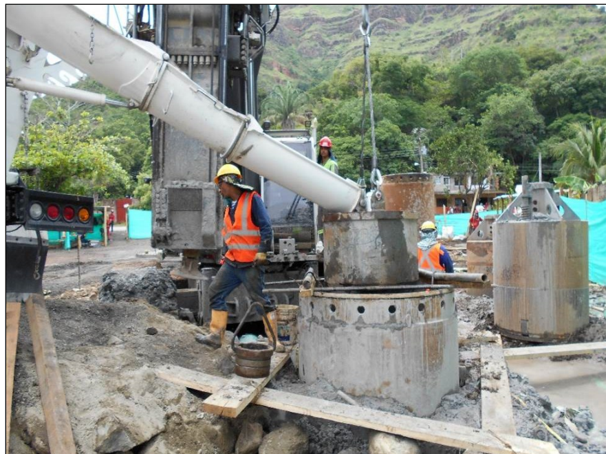
Figura 38: Pilotaje Eje 4. Fuente: Constructora Colpatría
