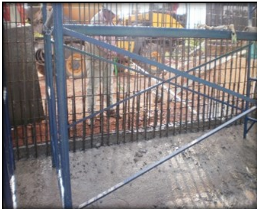
Figura 26: Preparación de superficie con chorro de agua. Fuente: Constructora Colpatria
