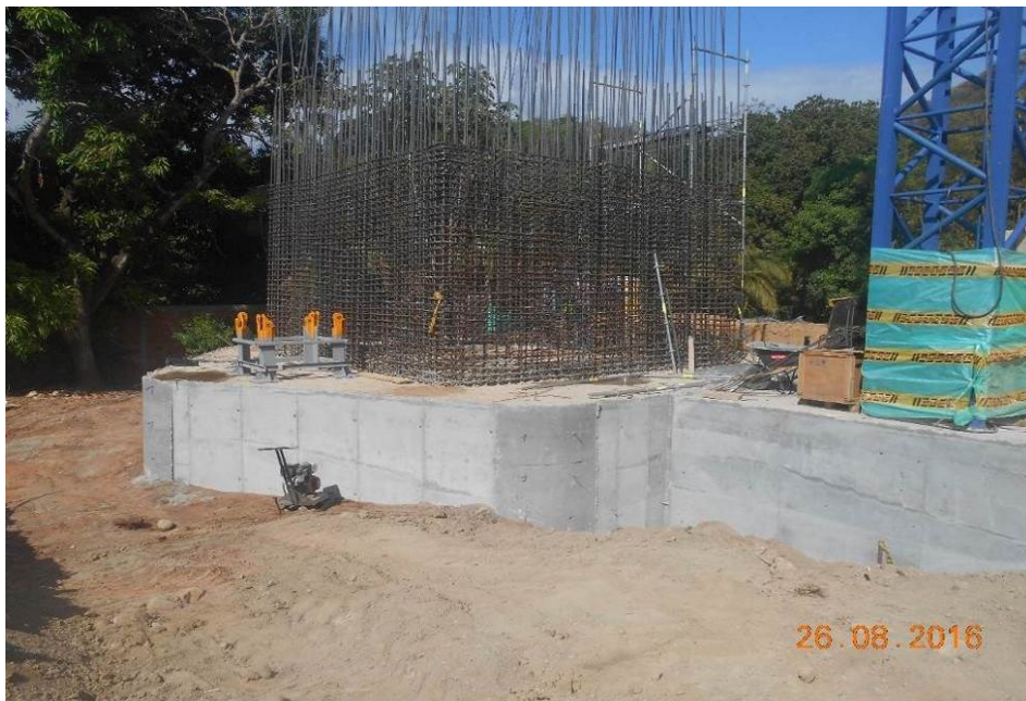
Figura 42: Armado de columna Eje 4. Fuente: Constructora Colpatria
