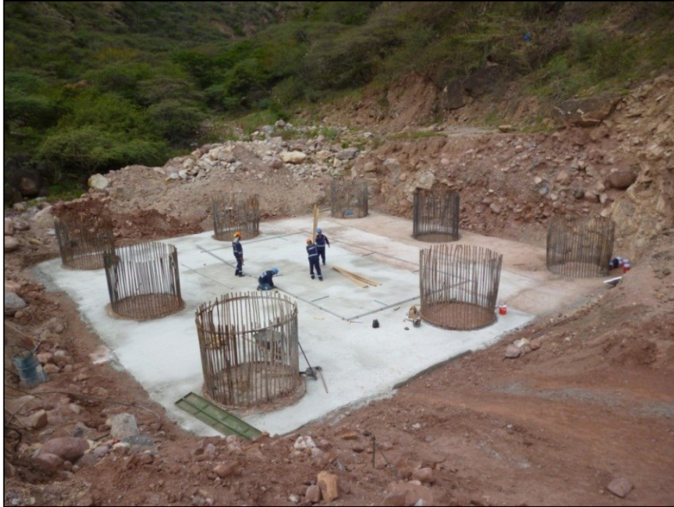
Figura 19: Placa de realce. Fuente: Constructora Colpatría
