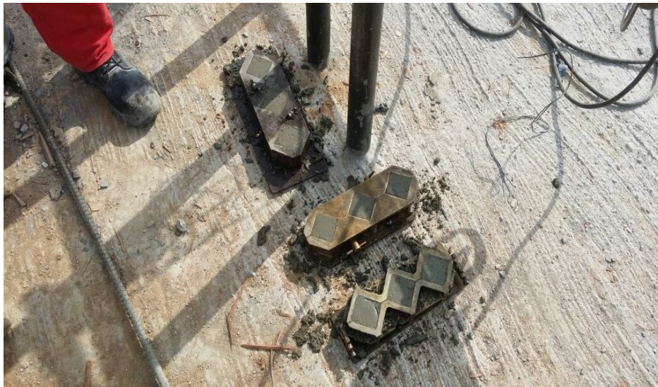
Figura 49: Control de calidad Grout de nivelación. Fuente: Constructora Colpatría
