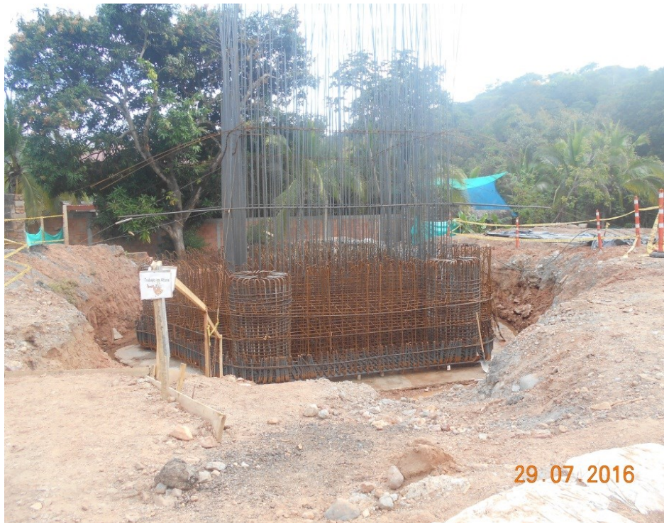
Figura 40: Armado de zapata Eje 4. Fuente: Constructora Colpatria
