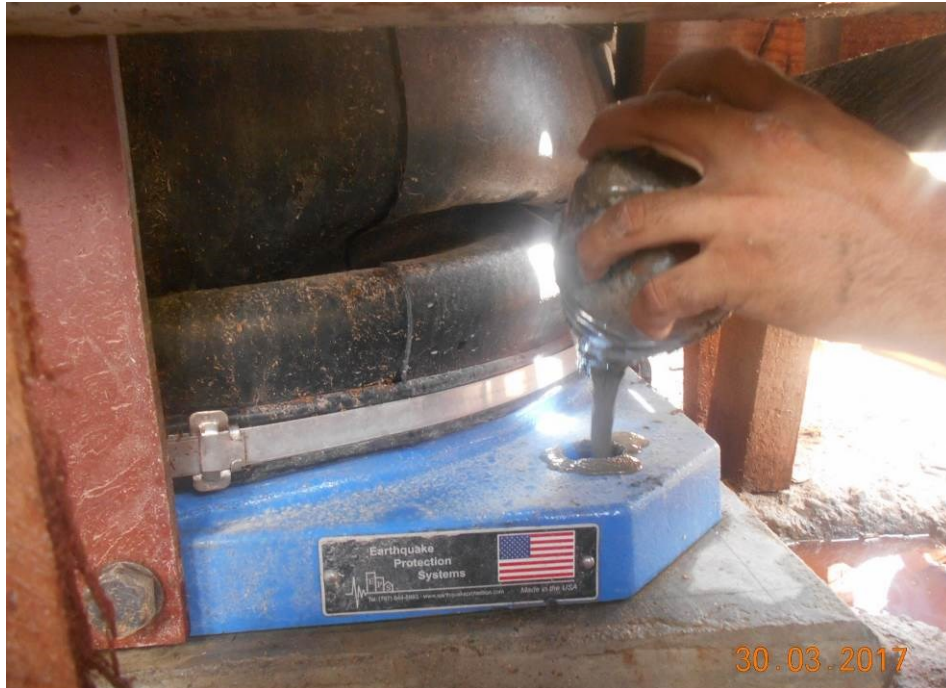
Figura 48: Instalación de aisladores sísmicos. Fuente: Constructora Colpatría
