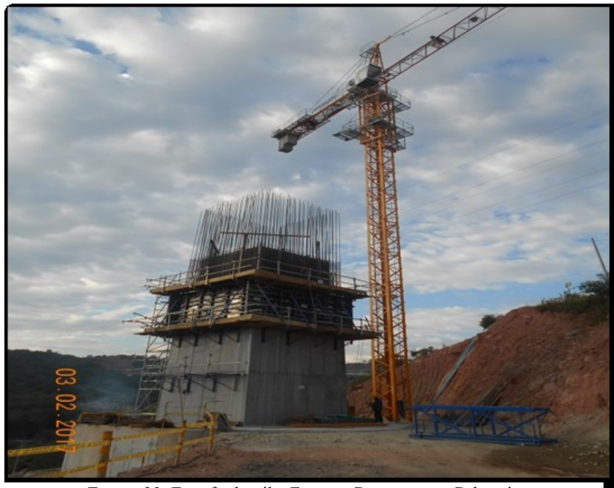
Figura 23: Encofrado pila. Fuente: Constructora Colpatría
