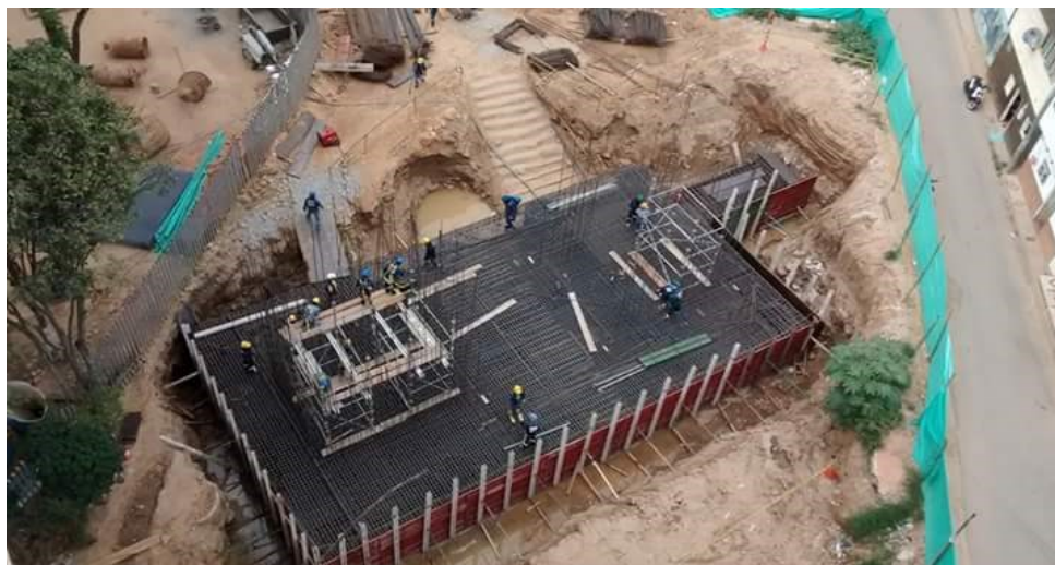
Figura 21: Encofrado del elemento. Fuente: Constructora Colpatria.
