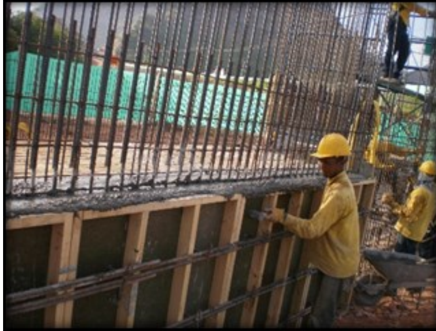
Figura 24: Revoque de concreto. Fuente: Constructora Colpatría
