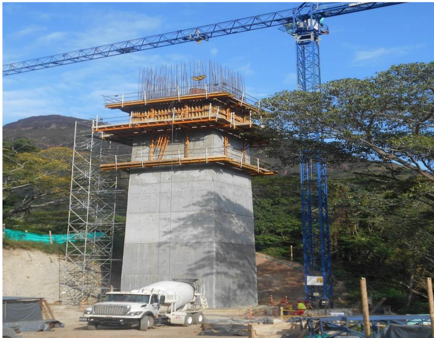
Figura 46: Pila Eje 5. Fuente: Constructora Colpatría
