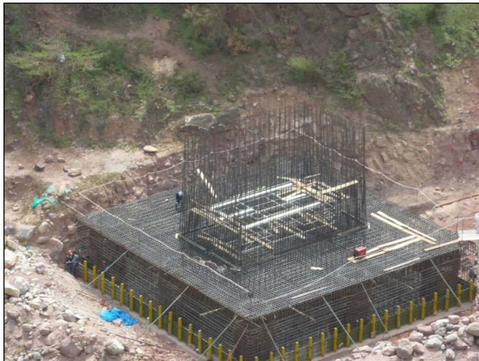
Figura 20: Armado de refuerzo zapata. Fuente: Constructora Colpatría
