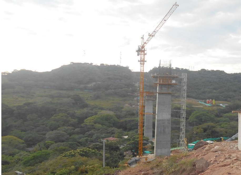
Figura 45: Pilas Viaducto Gualanday II. Fuente: Constructora Colpatría
