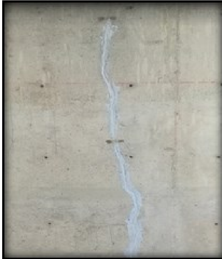
Figura 36: Colocación del material de sello. Fuente: Constructora Colpatria
