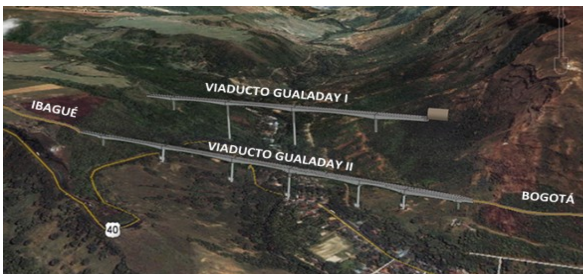
Figura 1: Viaducto Gualanday II. Fuente: Constructora Colpatría
