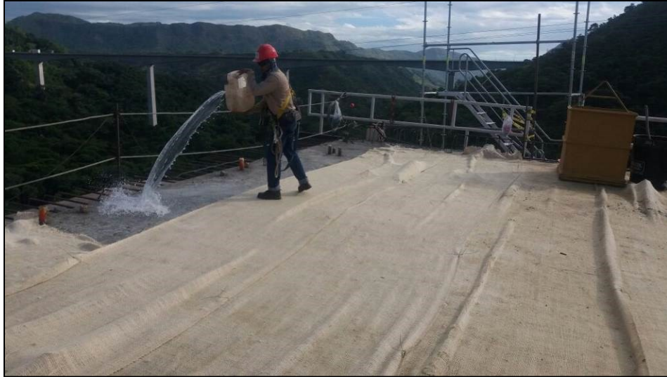
Figura 51: Curado fique losa superior dovela Eje 2. Fuente: Constructora Colpatría
