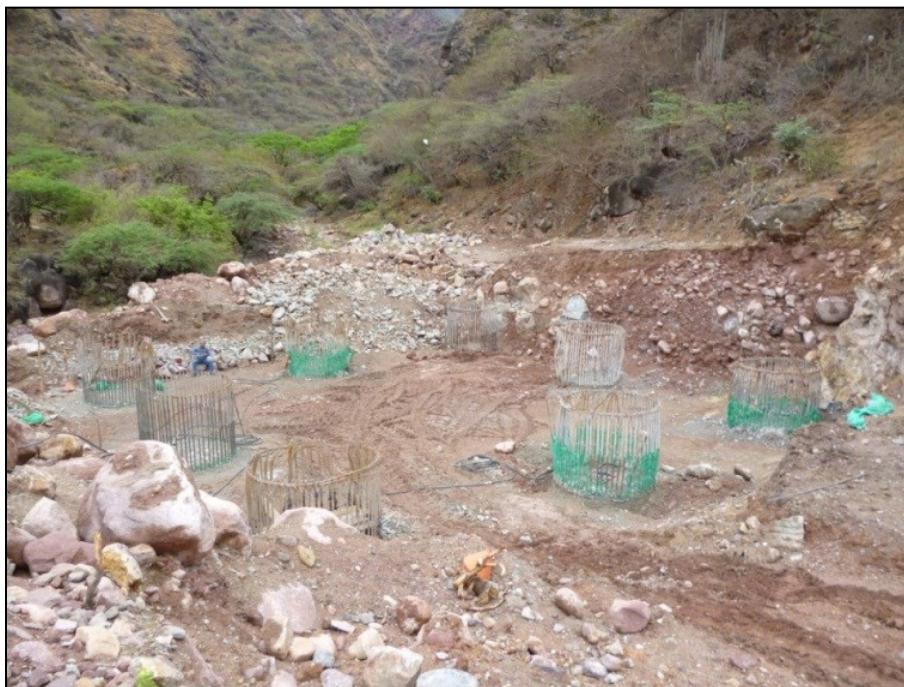
Figura 17: Descabece de pilotes. Fuente: Constructora Colpatría
