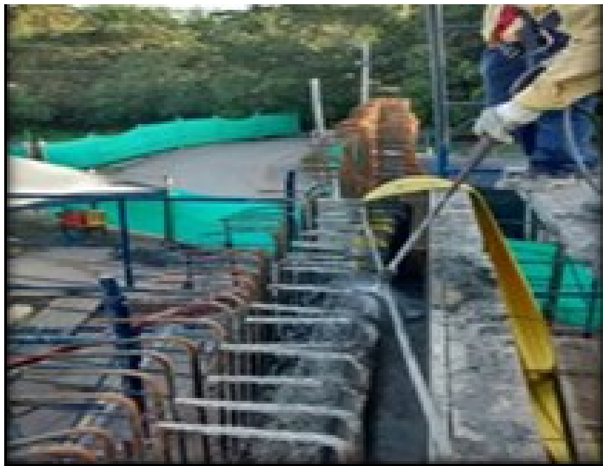
Figura 25: Preparación de superficie con chorro de agua. Fuente: Constructora Colpatría
