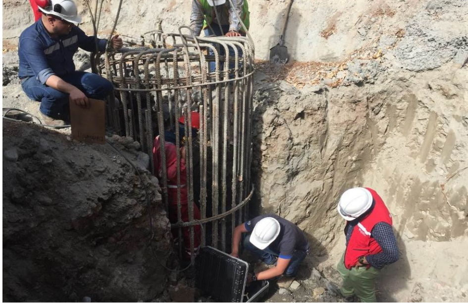
Figura 43: Pruebas de integridad a pilotes Eje 5. Fuente: Constructora Colpatría
