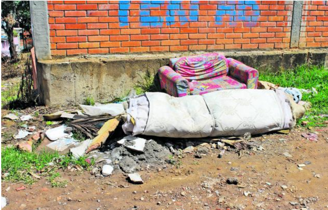
Figura 11. Evidencia del basurero que se evidencia debido al abandono del Centro Cultural. Fuente: Vanguardia Liberal.
