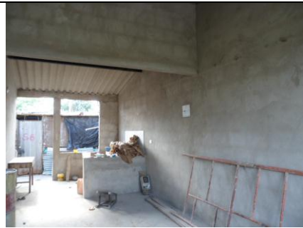
Foto 2. Vivienda pañetada en el interior
