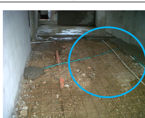
Foto 20. Placa tanque, instalación tubería
