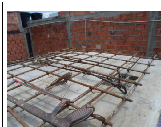
Foto 19. Instalación placa tanque
