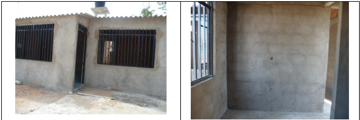
Foto 7. Vivienda pañetada a nivel de la viga aérea en su totalidad.
