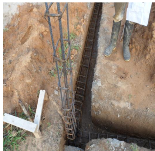
Foto 13. Armado refuerzo columnetas
