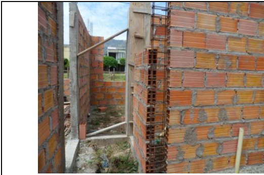
Foto 3. Vivienda en proceso.
