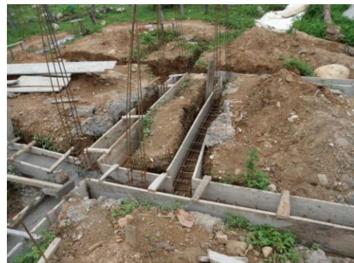
Foto 11. Construcción concreto ciclópeo. Foto 12. Construcción viga.
