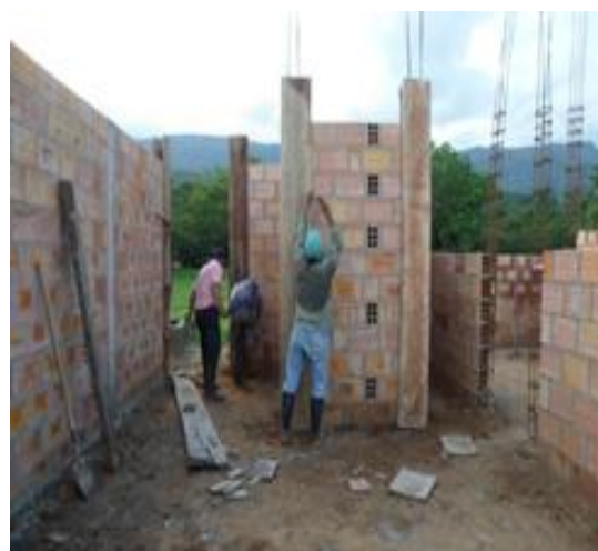
Foto 14. Alzado de Mampostería
