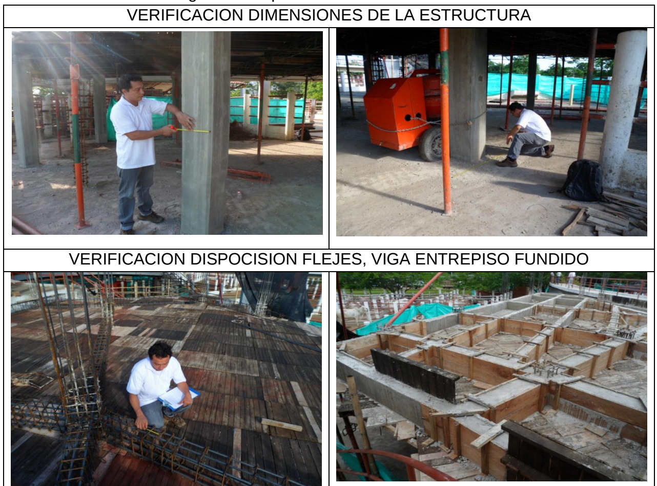
Foto 38. Construcción viga de entrepiso N+3.20
