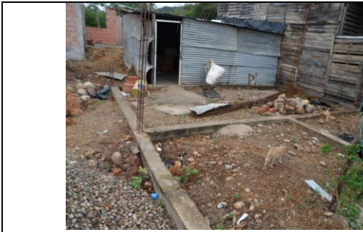
Foto 1. Cimentación existente
