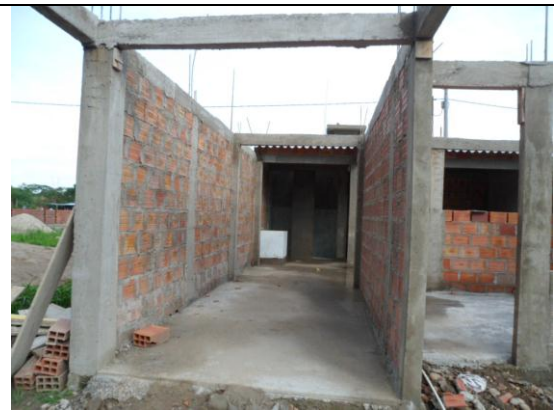
Foto 6. Proceso constructivo Placa de piso
