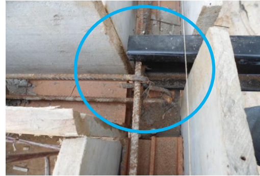
Foto 18. Refuerzo viga cinta y perfil
