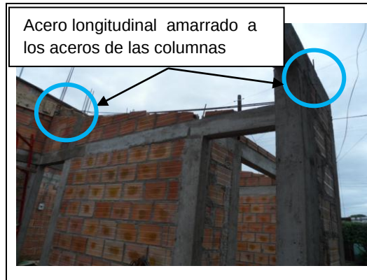
Foto 17. Proceso constructivo viga cinta
