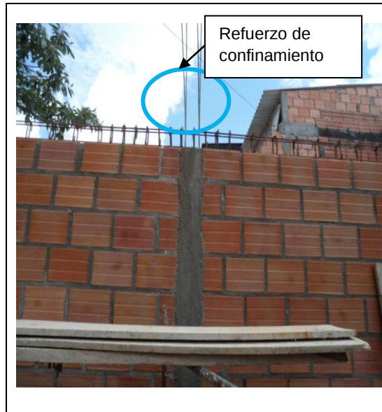
Foto 15. Proceso constructivo viga aérea
