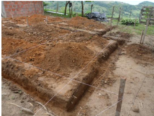
Foto 9. Localización y replanteo
