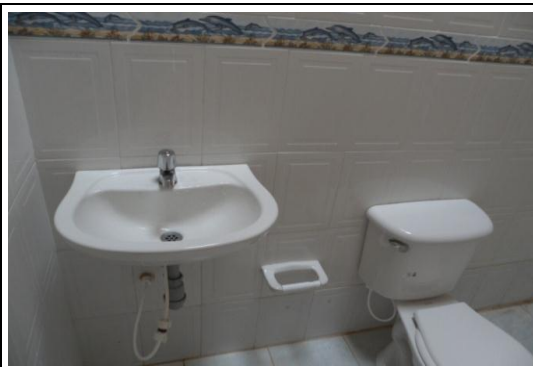
Foto 21. Instalación aparatos sanitarios
