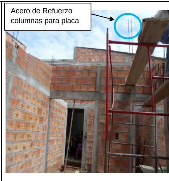
Foto 16. Construcción cuchillas
