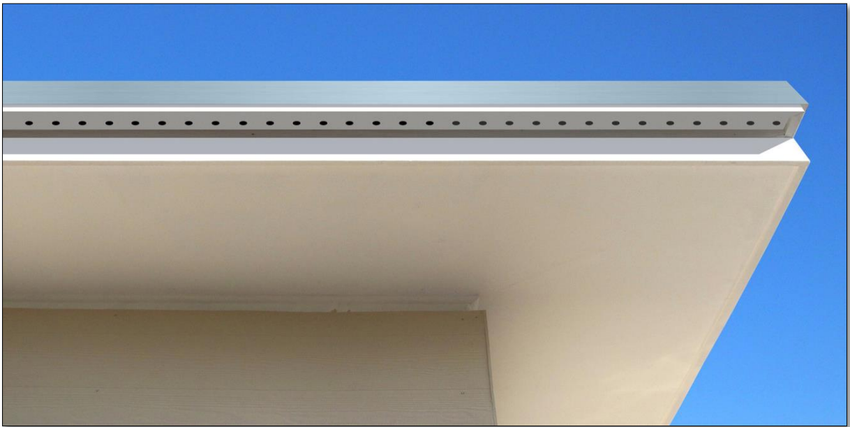
Figura 42 Ventilación para cubierta
