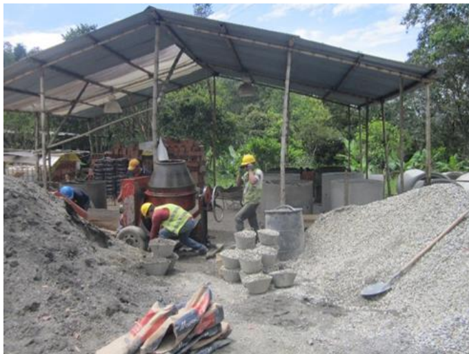
Imagen 11. Fabricación de tubería de 4000 PSI # 3/8
