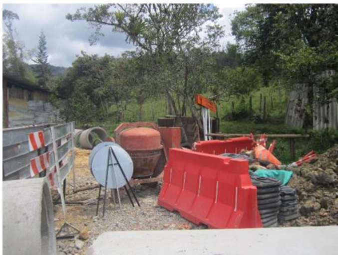
Imagen 12. Equipo de obra y señalización de transito
