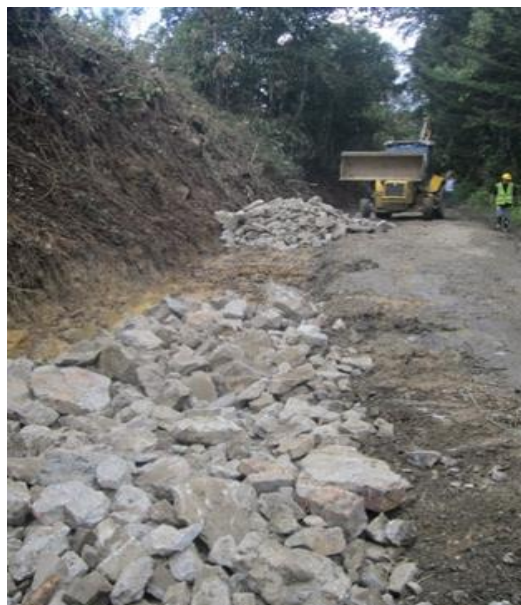
Imagen 13. construcción de pedraplén L: 120 m y a: 2.8 m.
