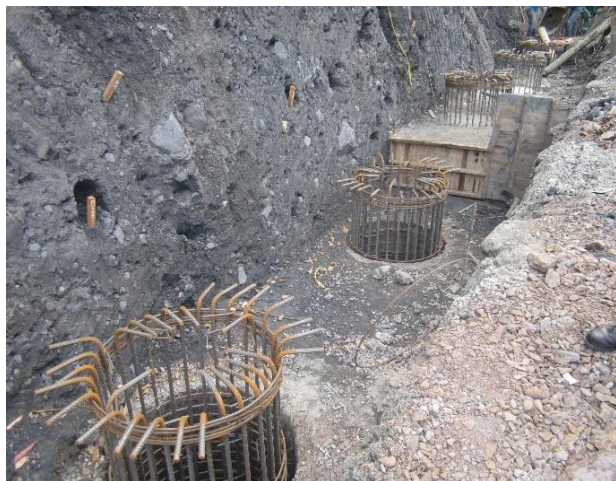
Imagen 26. Construcción de caisson
