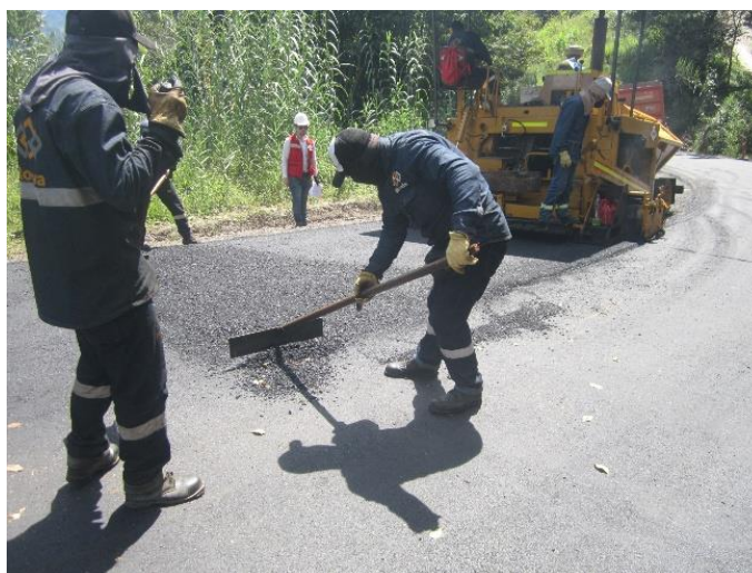
Imagen 21. Cuadrilla en labores de pavimentación
