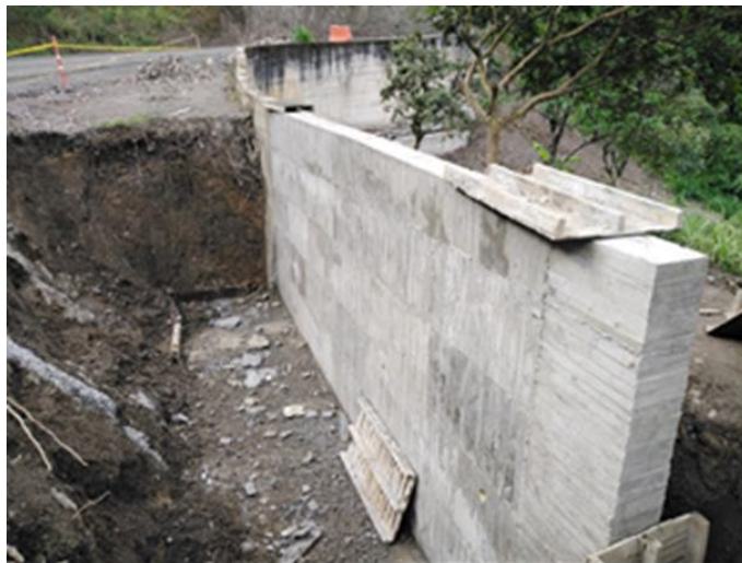
Imagen 17. Muros de contención en concreto reforzado
