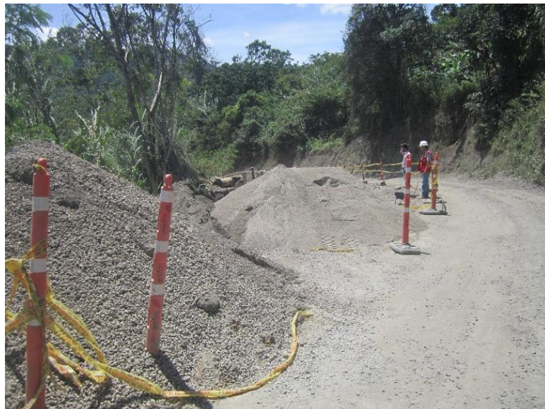
Imagen 15. material de obra, señalizacion y trabajadores en obra
