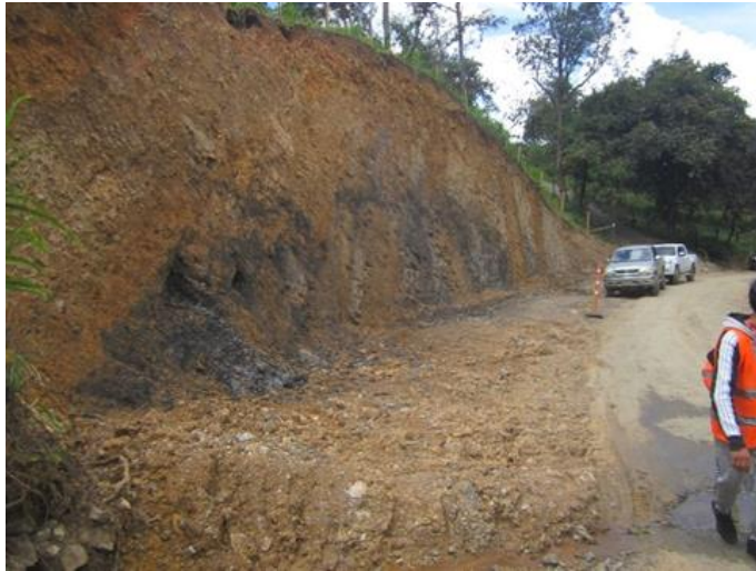
Imagen 10. corte de talud y ampliación de vía.
