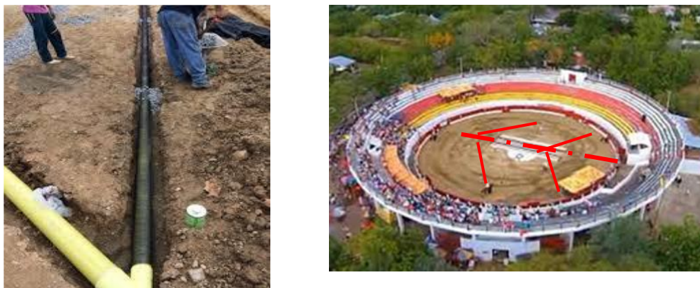
Figura 30. Esquema de Drenaje Espina de Pescado (Izquierda), Propia (Derecha). Fuente adaptado de Quintero & González (2018)
