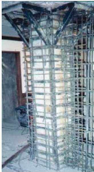
Figura 32. Sistema Convencional de Encamisado. Fuente: Sika (2017, p. 15)
