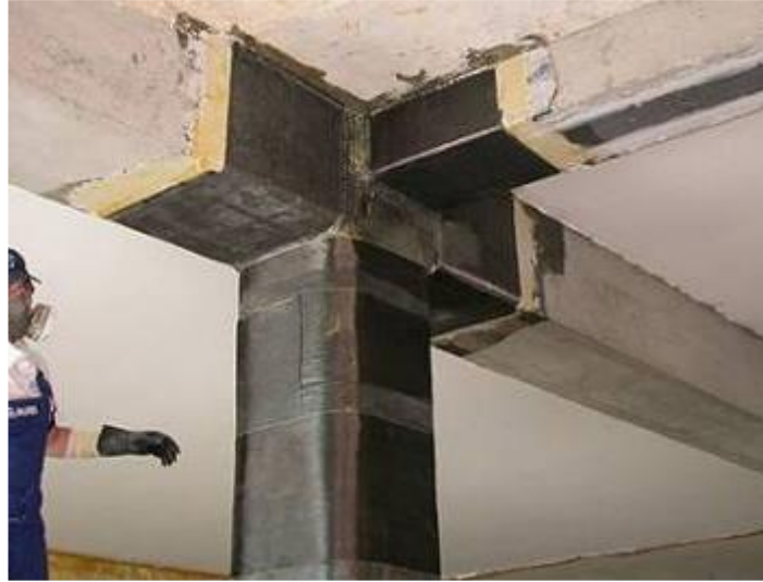
Figura 33. Sistema RFP (Manto Fibra Carbono). Fuente: Construyaprende (2014)
