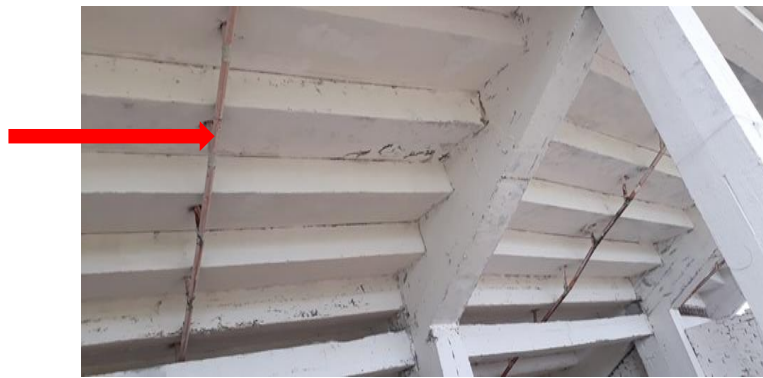
Figura 23. Instalación de Sistema de Evacuación de Aguas Lluvias. Fuente: elaboración propia
