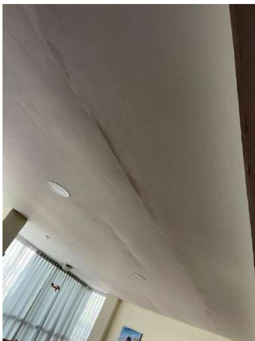
Figura 8. Muestra del desplazamiento de la vivienda.
