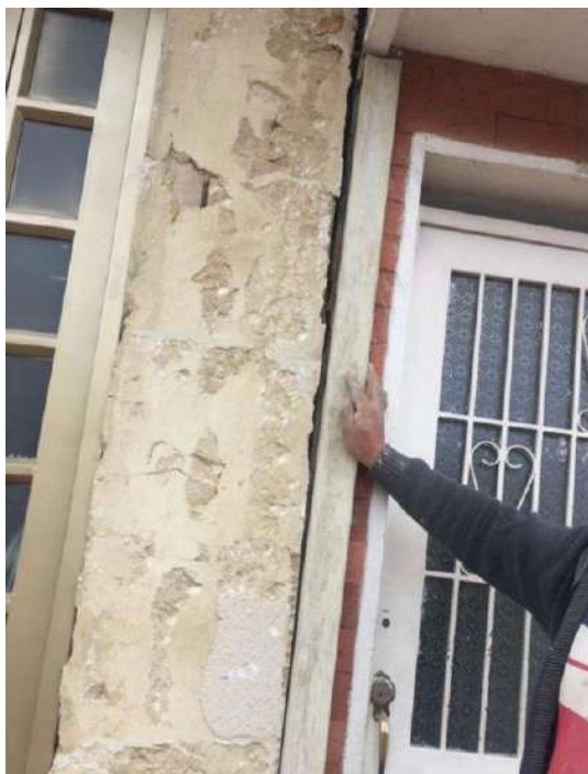
Figura 8. Muestra del desplazamiento de la vivienda.
