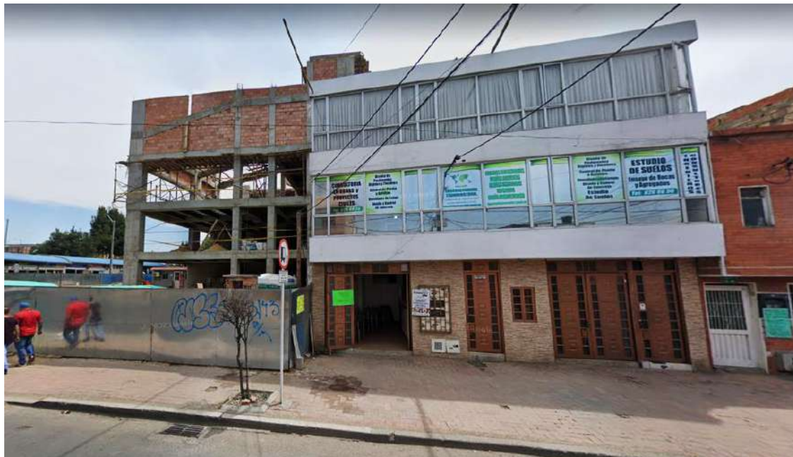
Figura 5. Fotografía del Proyecto afectado y construcción aledaña.
