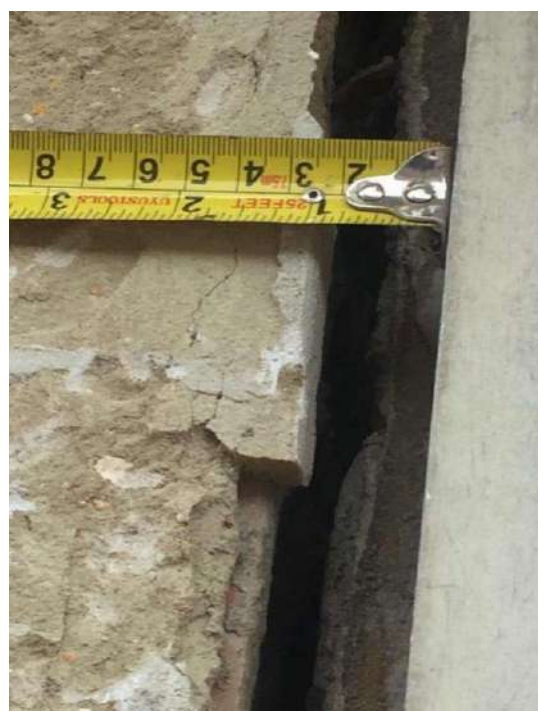
Figura 9. Toma de medida del desplazamiento.
