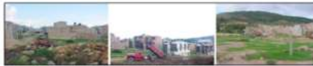
Figura 80. Descargue de material para relleno del predio.
