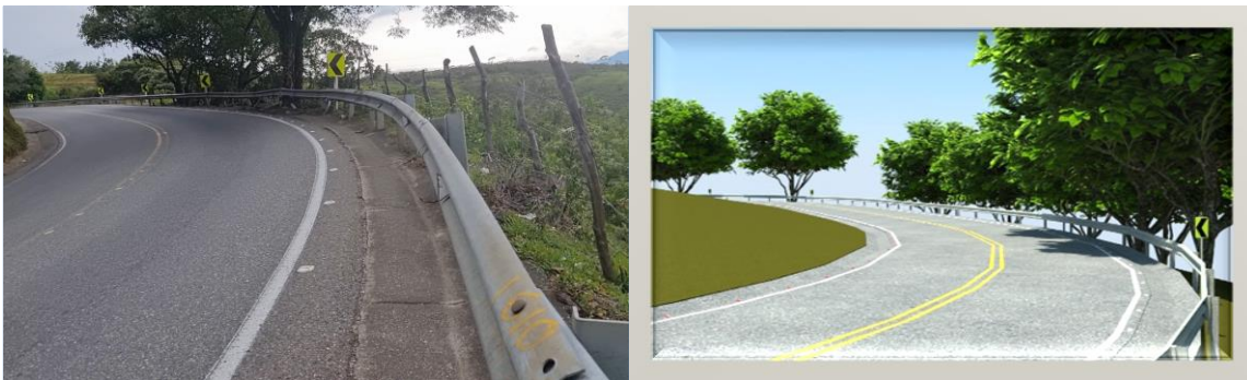
Figura 37 Reubicación de los DCH y de la barrera metálica fuera de la cuneta lateral
