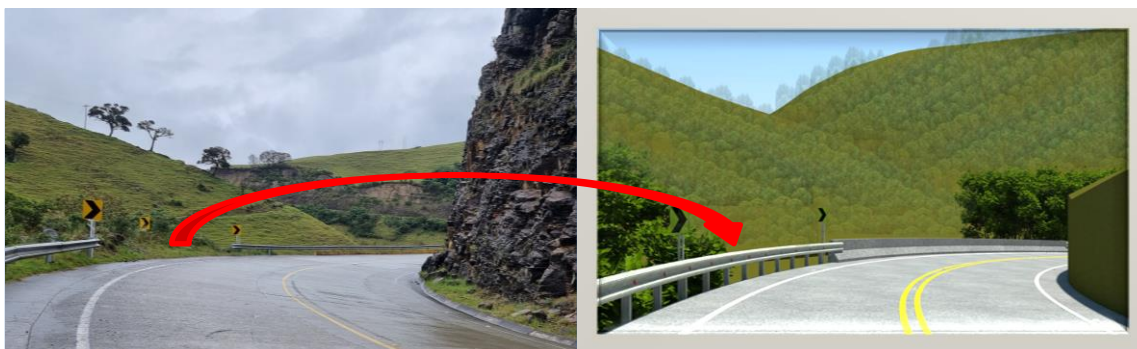
Figura 52 Continuidad barrera metálica
