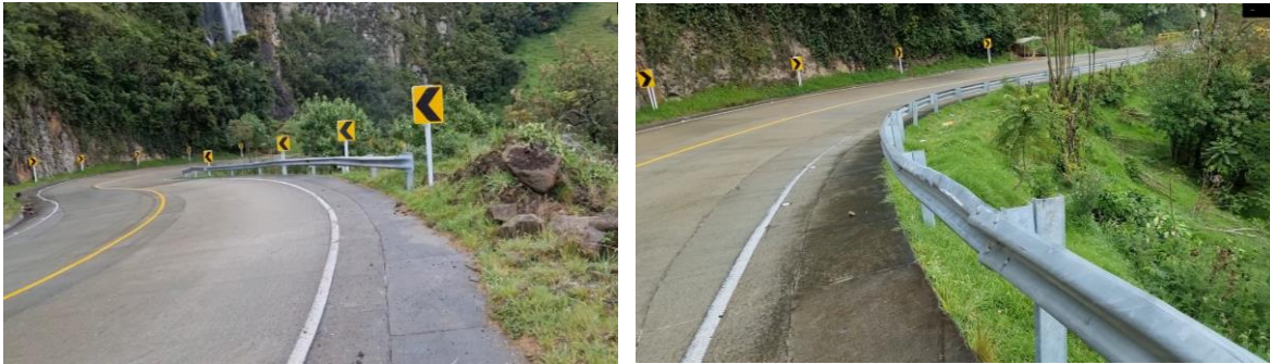
Figura 48 Registro fotográfico señalización existente – Ruta 2002 (PR 34+040 a PR 34+400)
