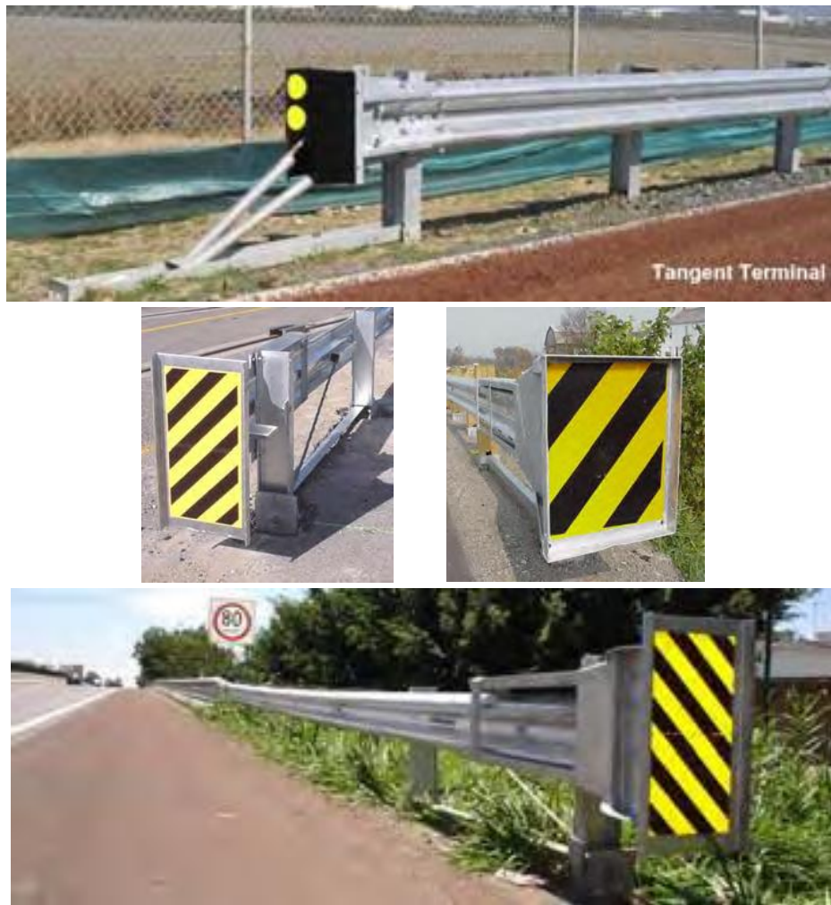
Figura 16 Ejemplos de Terminal Atenuador de Impacto
