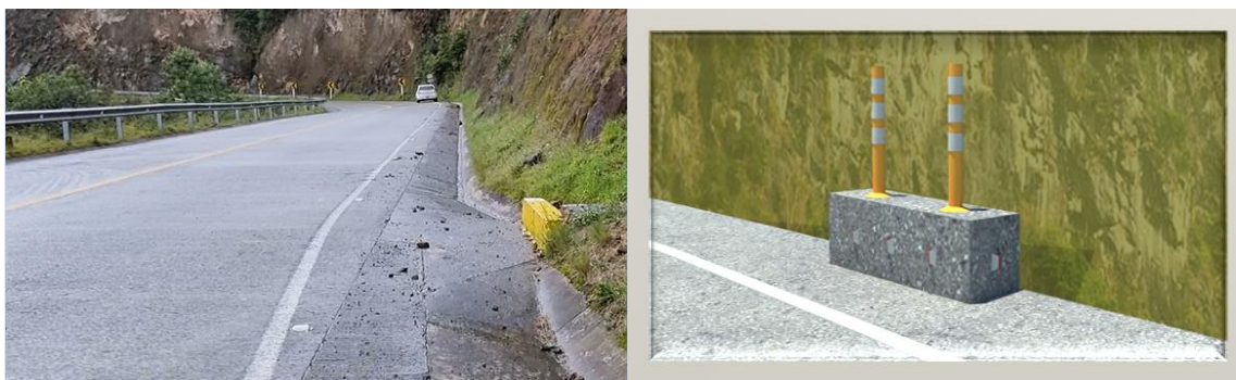
Figura 53 Señalización de obstáculo lateral
