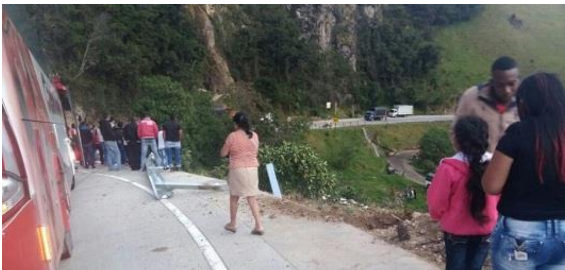
Figura 47 Registro impacto contra barrera metálica Ruta 2002 (PR 34+200 a PR 34+250)
