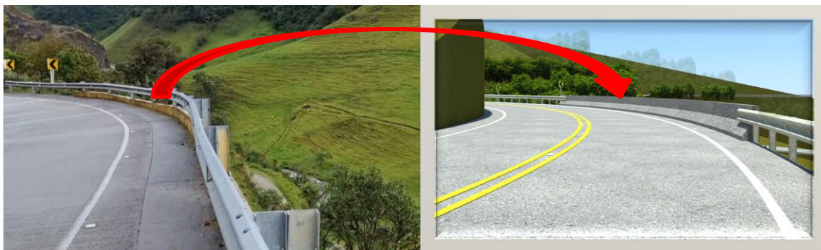
Figura 51 Instalación sistema de contención rígido “Sector abismo”
