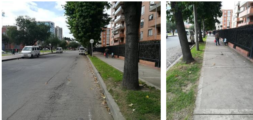
Figura 1: Efectos desfavorables de materiales expansivos en el noroccidente de la ciudad de Bogotá, Colombia. Nota: Elaboración propia
