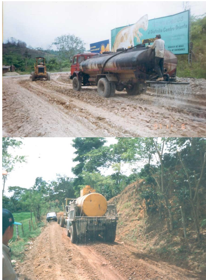
Figura 16: Irrigación de material granular con aceite sulfonado. (Estavías, 2008)
