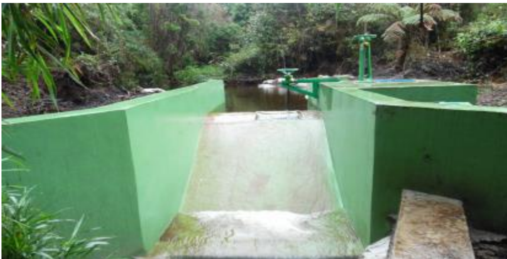
Figura 14. Fotografía de Bocatoma y caja de derivación cota K00+00
