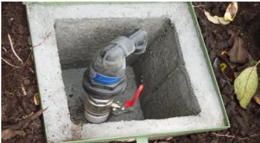
Figura 22. Instalación de válvulas ventosas
