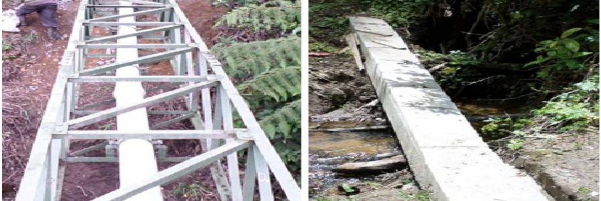
Figura 27. Pasos elevados. Instalación de estructura metálica para los pasos elevados soporte de la tubería de diámetro 8" y 6" k0+700 y k0+ 740
