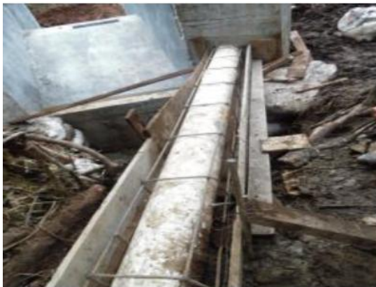
Figura 16. Fotografía de la línea de aducción diámetro 8" y con refuerzo de concreto, tomado en la cota k0+015
