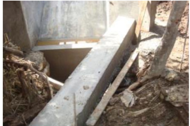
Figura 16. Fotografía de la línea de aducción diámetro 8" y con refuerzo de concreto, tomado en la cota k0+015
