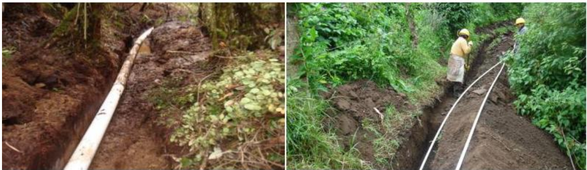
Figura 20. Imagen de la Instalación de la tubería conducción principal ubicada en la cota inicial K0+015 hasta K2+866.
