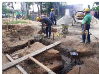
Vaciado de viga de cimentación
