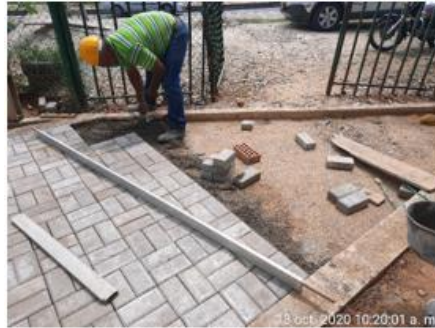
Instalación de adoquín en sendero principal
