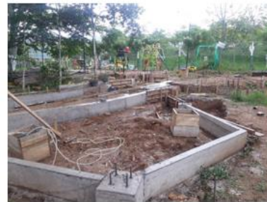
Bordillos y pedestales fundidos
