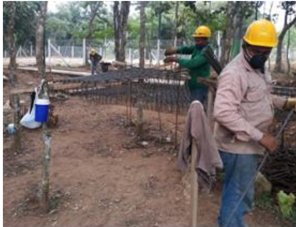
Armado de refuerzo estructural zapatas
