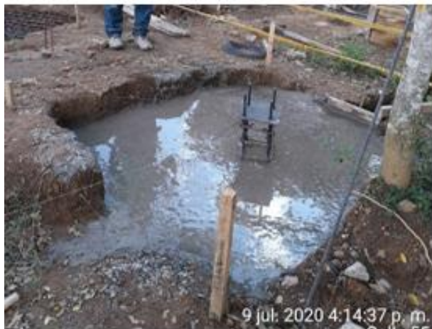
Vaciado de zapatas
