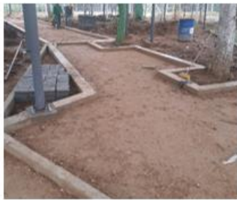
Terreno preparado para instalación de adoquín
