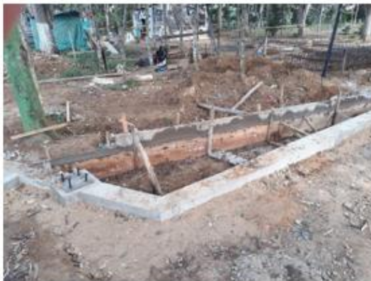
Vaciado de bordillo de plazoleta
