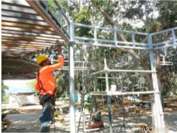
Aplicación pintura anticorrosiva
