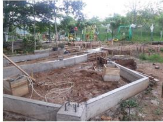
Bordillos y pedestales fundidos
