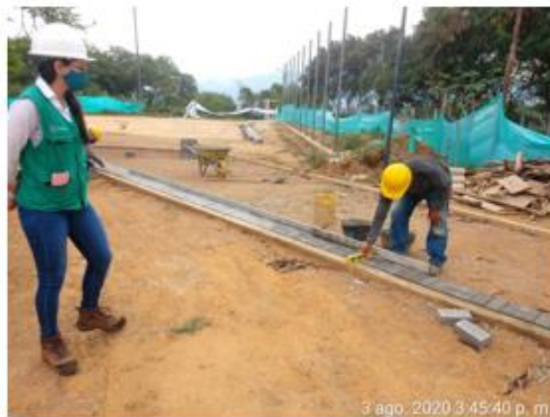
Supervisión instalación de adoquín, frente Monterredondo
