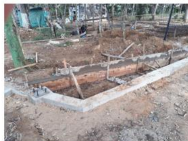
Vaciado de bordillo de plazoleta
