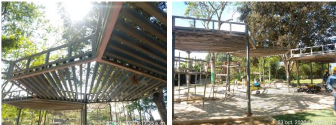
Figura 16. Pérgolas instaladas en obra. Figura autor.
