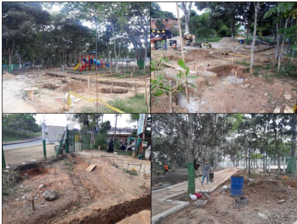
Figura 5. Estado de la obra al iniciar la práctica. Figura autor
