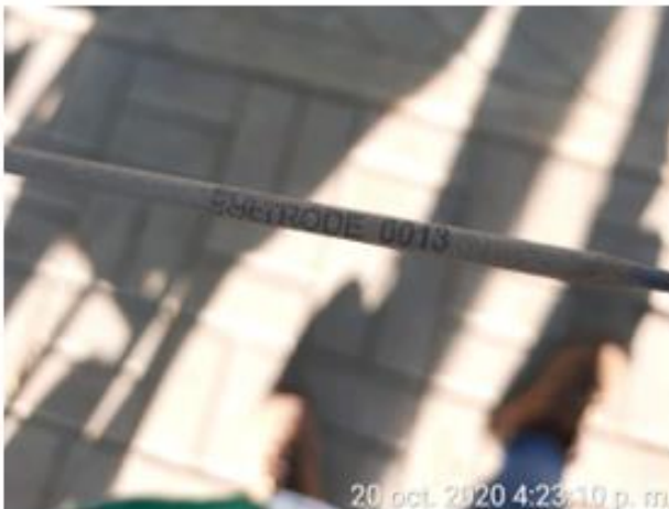
Soldadura aplicada para los pegues de la cercha
