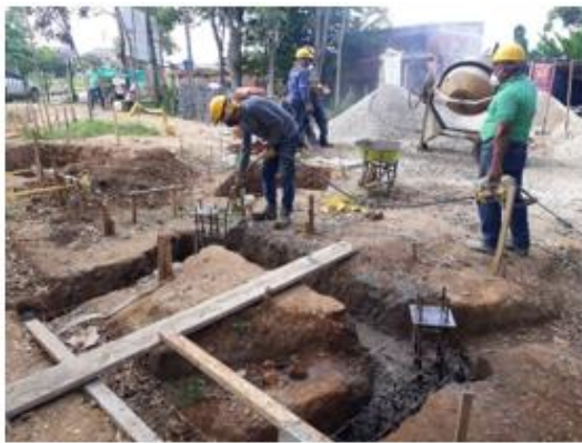
Vaciado de viga de cimentación
