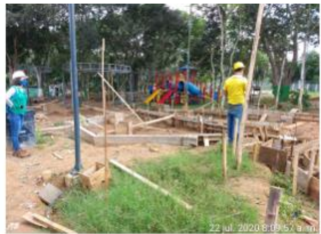
Supervisión encofrada de pedestales
