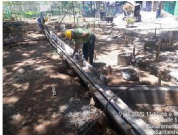
Vaciado de bordillo sendero principal
