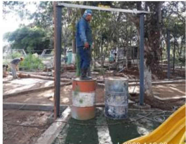
Instalación de columnas
