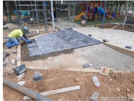
Instalación de adoquín en plazoleta
