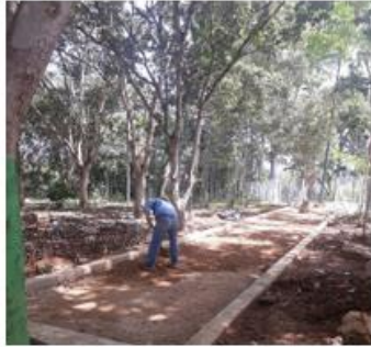
Aplicación de subbase en sendero principal
