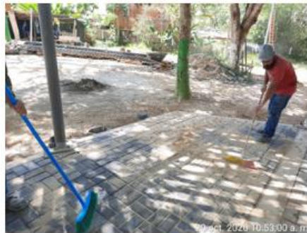
Brechado de adoquín con arena
