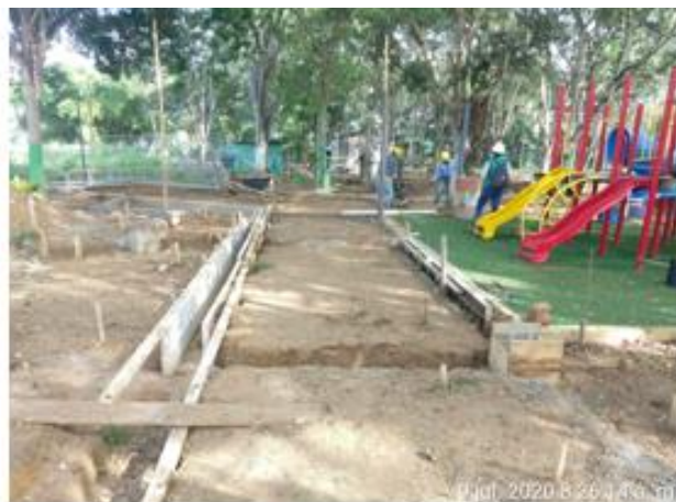
Supervisión encofrada de bordillos
