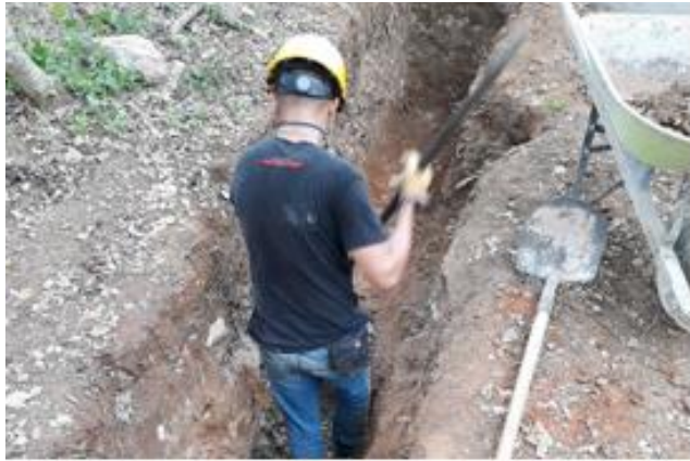
Excavación filtro francés
