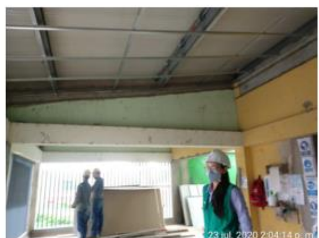
Visita de obra frente Santander
