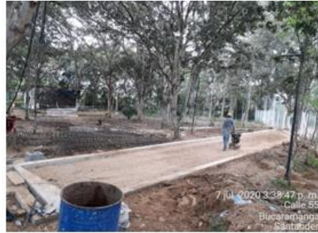
Compactación de subbase granular
