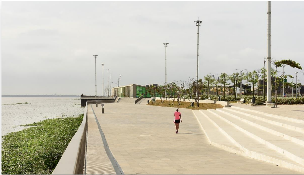
Figura 12. Fotografía detalle pavimentos Gran Malecón de Barranquilla
