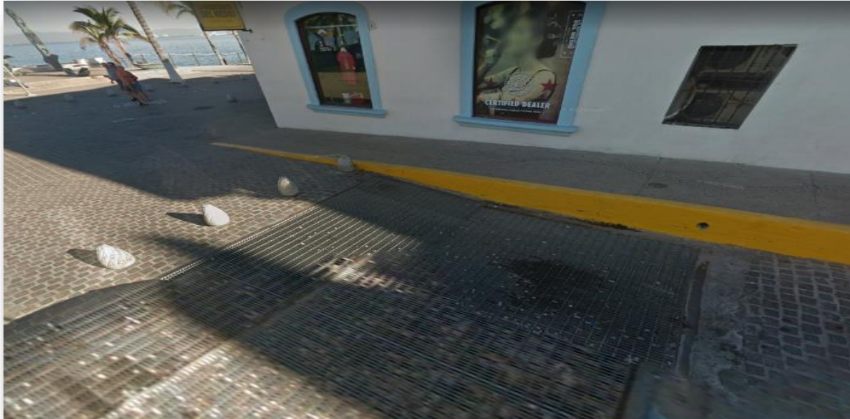
Figura 19. Fotografía detalle sumidero Malecón de Puerto Vallarta
