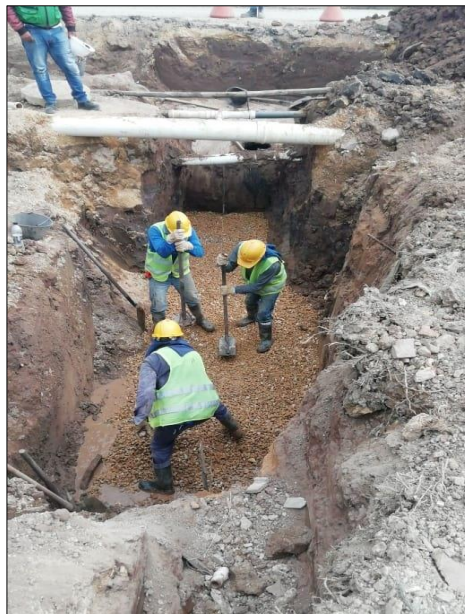
Imagen 10. Distribución uniforme de triturado (Grava)
