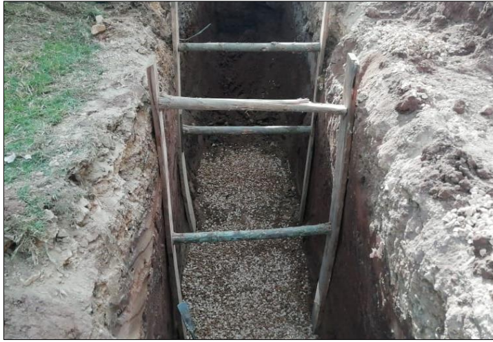
Imagen 21. Instalación entibados
