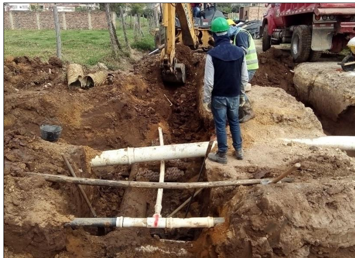
Imagen 8. Excavación e instalación tubería
