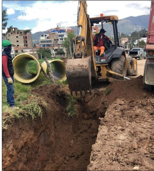
Imagen 9. Excavación e instalación tubería
