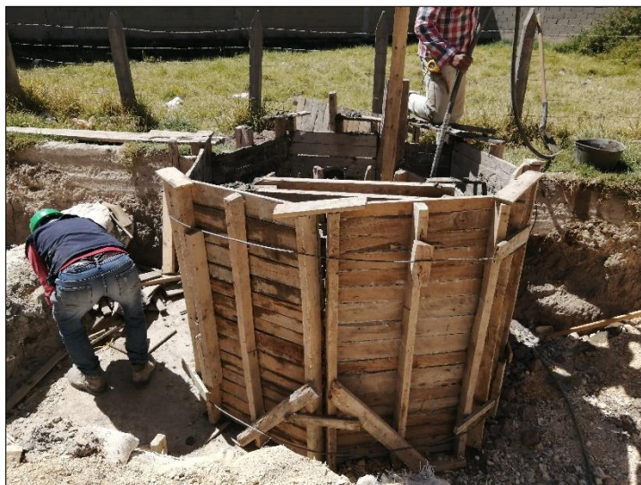
Imagen 32. Formaleta en madera para cilindro de acceso
