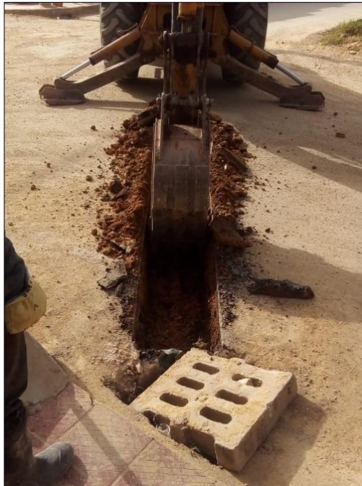
Imagen 25. Demolición sumideros existentes
