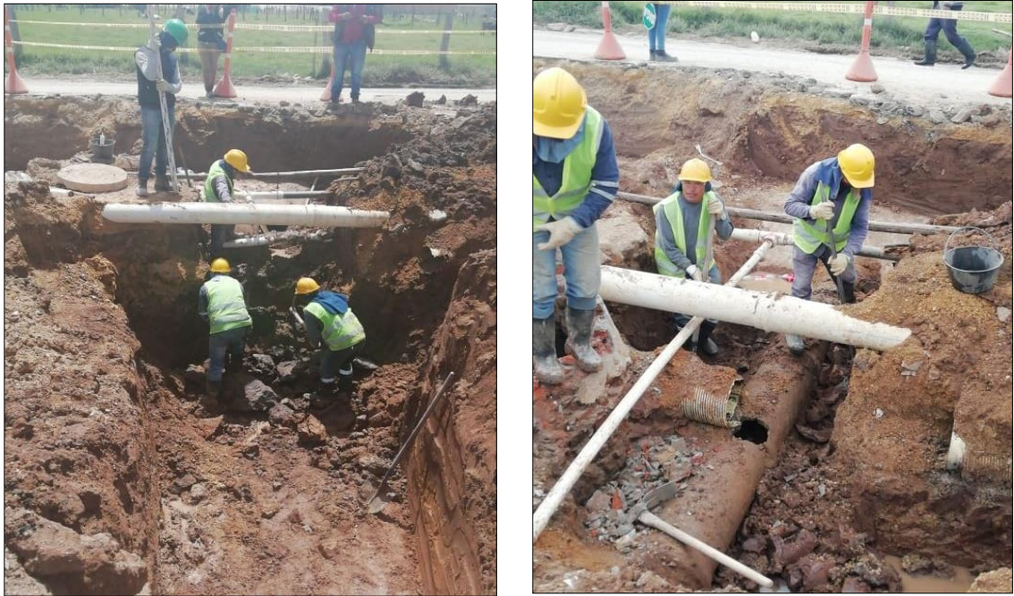
Imagen 5. Excavación localización redes existente carrera 35 con calle 14
