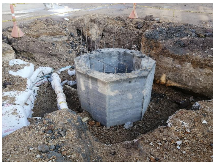
Imagen 33. Cilindro de acceso vaciado en sitio con espesor de muros de 25 cm reforzado
