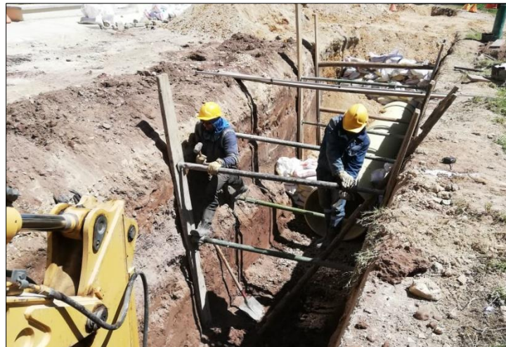
Imagen 22. Instalación entibados
