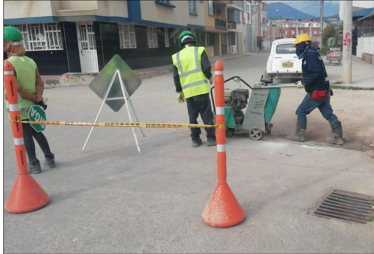
Imagen 23. Corte de asfalto calle 10 con avenida circunvalar para continuar con excavación
