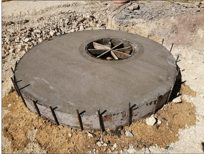
Imagen 34. Placa vehicular de 20 cm fundida en sitio
