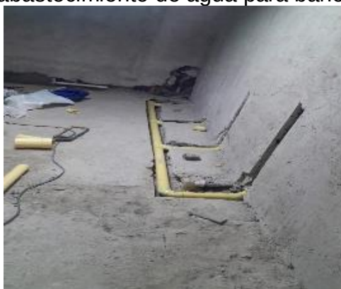
Figura 17 Instalación de tuberías de abastecimiento de agua para baños
