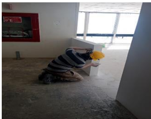
Figura 16 Acabados en muros
