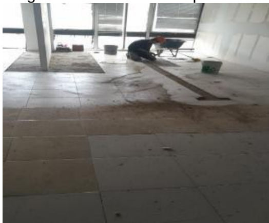
Figura 14 Instalación de piso SPC
