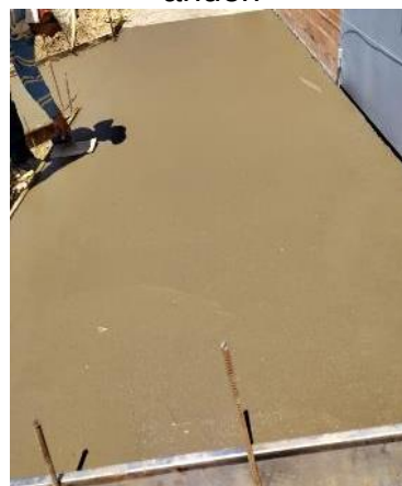
Figura 12 Aplicación de concreto en el andén
