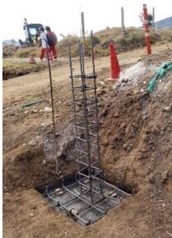
Figura 9 Construcción de zapata aislada
