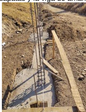
Figura 10 Aplicación de concreto a las zapatas y la viga de amarre
