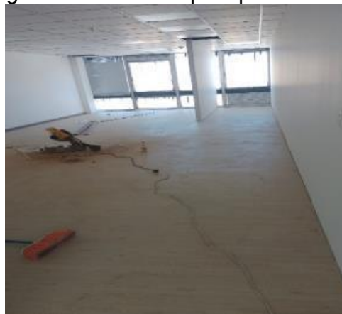
Figura 15 Acabo de piso para oficinas
