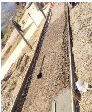
Figura 11 Refuerzo del andén
