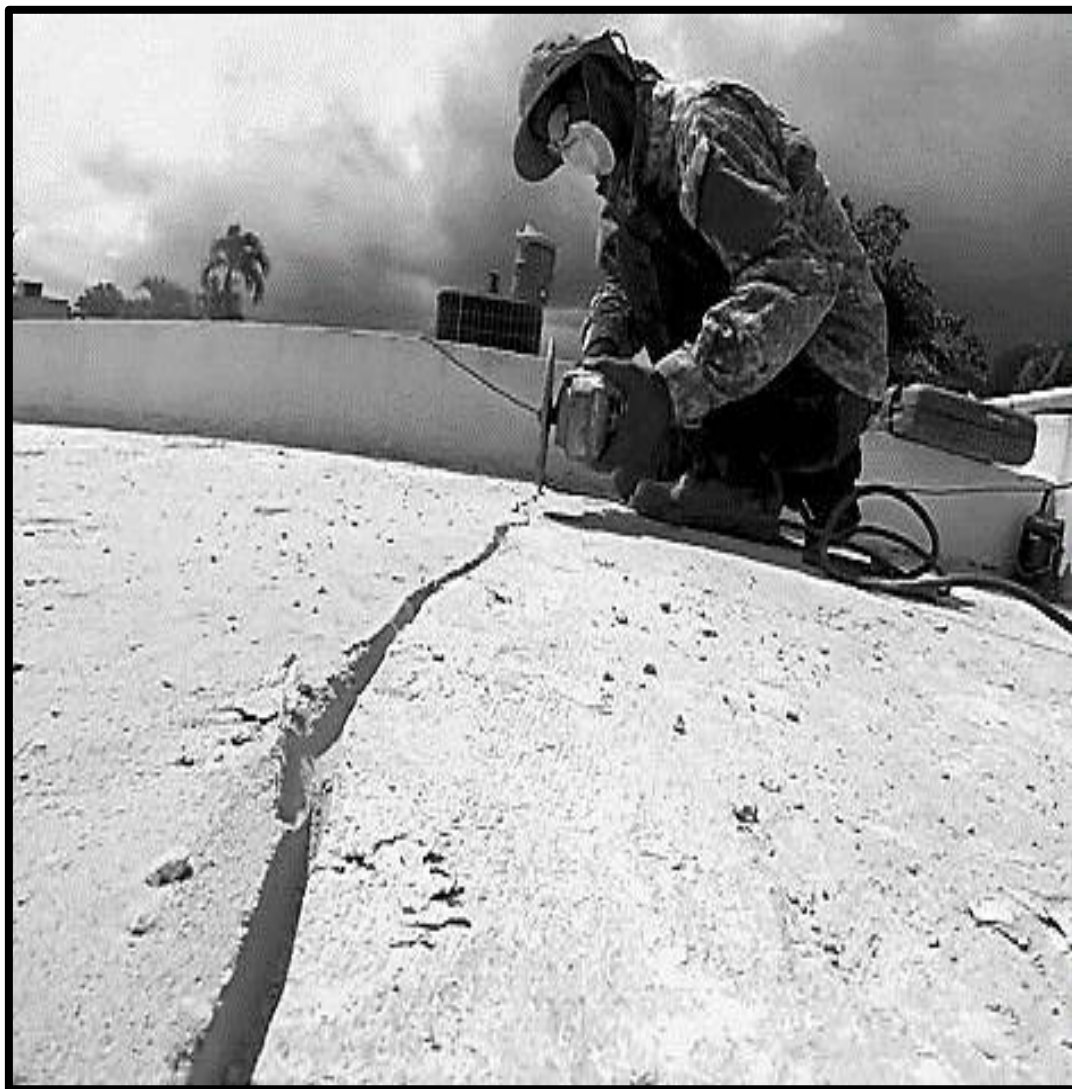
Figura 40. Ejemplo de ruteo de fisuras
