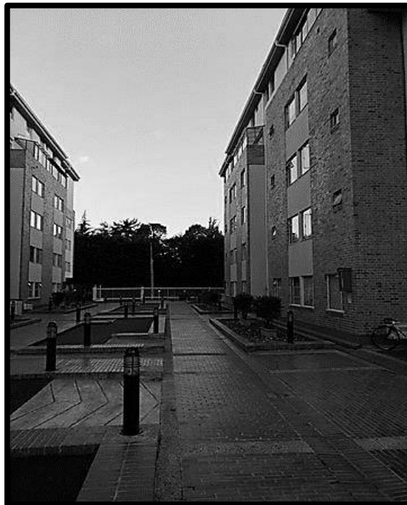
Figura 35. Vista de la plazoleta en primer piso, bajo esta zona se encuentra el sótano con las patologías ya mostradas y relacionadas. Fuente: Los autores
