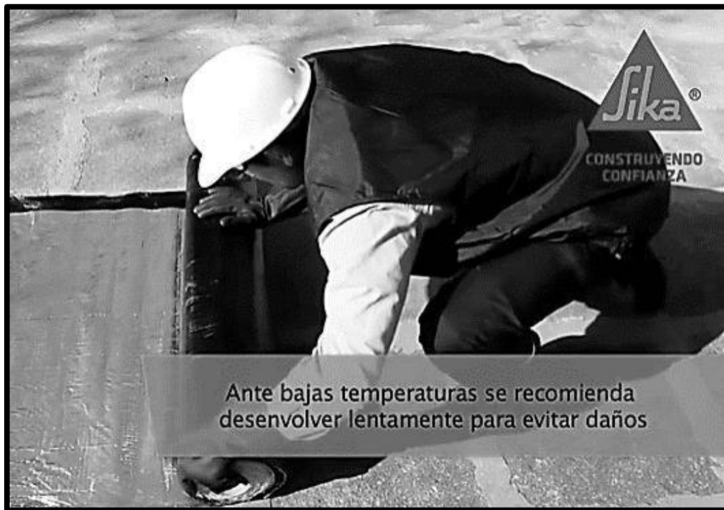
Figura 42. Muestra instalación de Sikamanto
