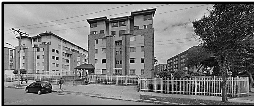
Figura 3. Frente conjunto residencial la Estancia I. Foto tomada de Google Earth
