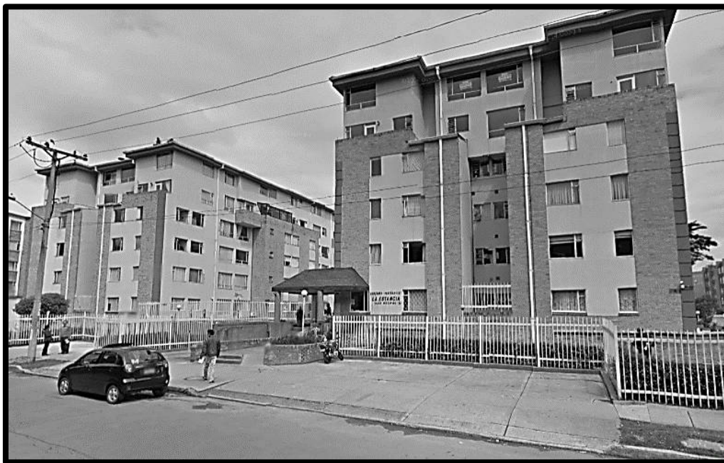
Figura 14. Fachada principal lado sur conjunto. Fuente los autores
