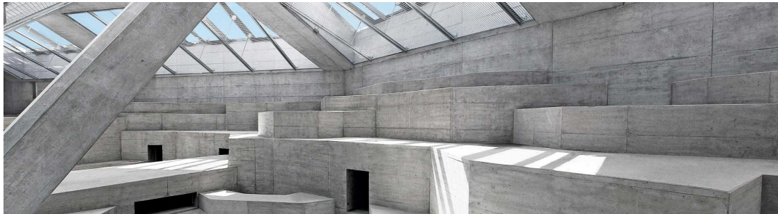
Figura 42. Concreto a la Vista Usado en Estructura, Paredes y Cubierta
