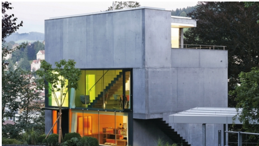
Figura 41. Edificación construida en concreto a la vista
