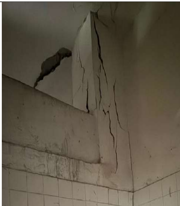
Imagen 7 y 8 Lesiones en columnas piso 1 sector oriental y occidental.
