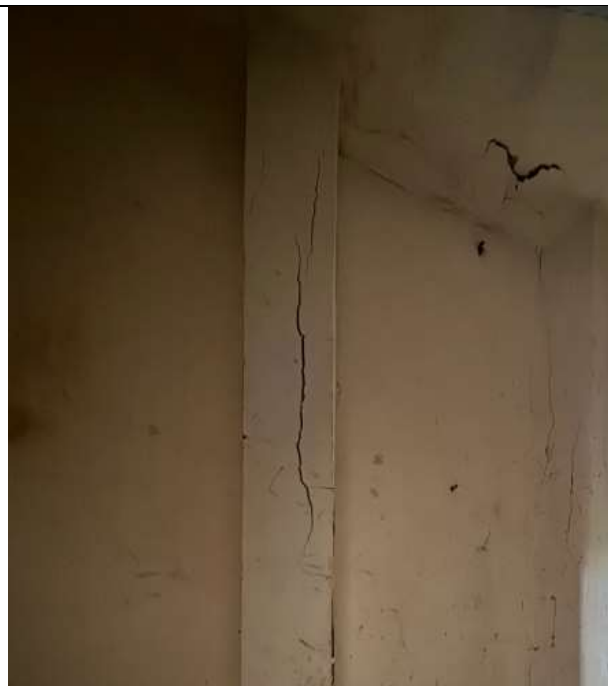
Imagen 7 y 8 Lesiones en columnas piso 1 sector oriental y occidental.
