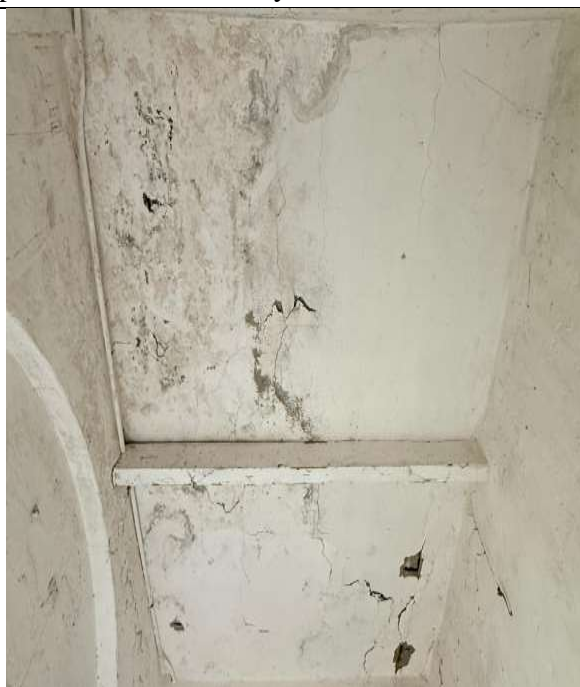
Imagen 9 y 10 Desprendimiento del concreto, corrosión del acero de refuerzo y eflorescencias en la losa de entrepiso del sector norte.
