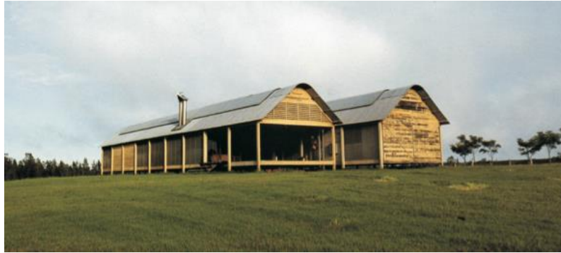
Figura 40. Vivienda unifamiliar en Australia.
