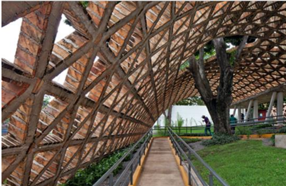
Figura 16. Análisis textura y color centro de rehabilitación Teletón
