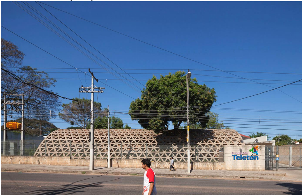
Figura 12. Fachada acceso principal Teletón
