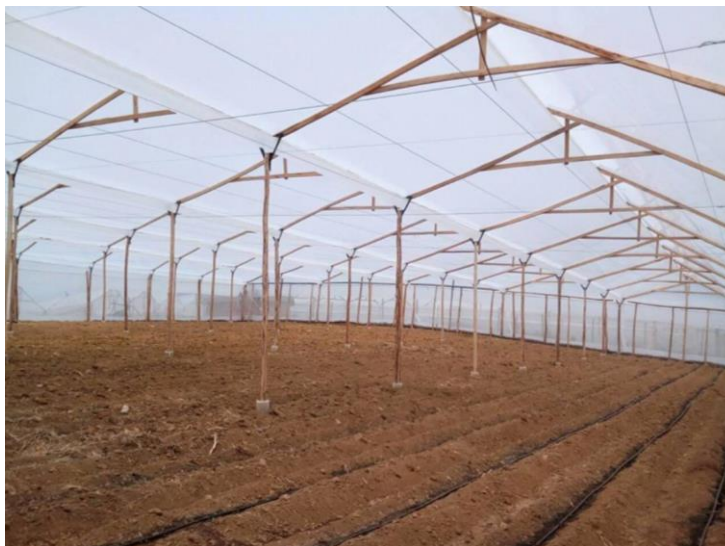
Figura 11. Estructura del invernadero con surcos preparados para la siembra.
