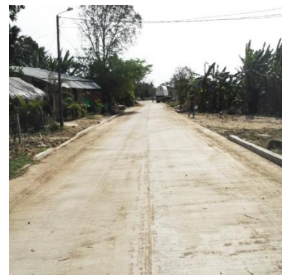
Tramo de la vía circunvalar en Pavimento Rígido , ver plano diseño y tabla No 1 del anexo No1
