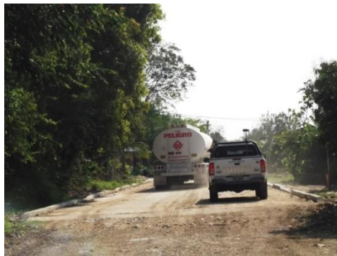
Tramo de la vía circunvalar en Pavimento Rígido K0+800, ver plano diseño y tabla No 1 del anexo No1
