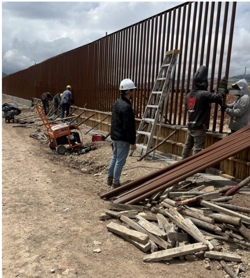
FIGURA 4: SUPERVISIÓN DE PERSONAL EN OBRA
