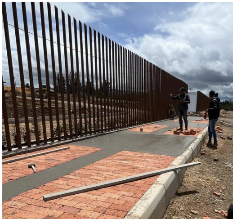
FIGURA 11: CONFORMACIÓN DE ANDÉN DE PASO PEATONAL.
