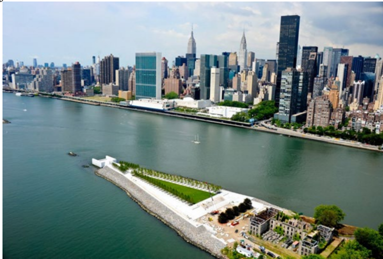
Figura 2. Fotografía reciente de Four Freedoms Park
