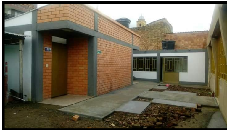
Fotografía 17. Unidades Sanitarias para Bodega Municipio de Tibaná
