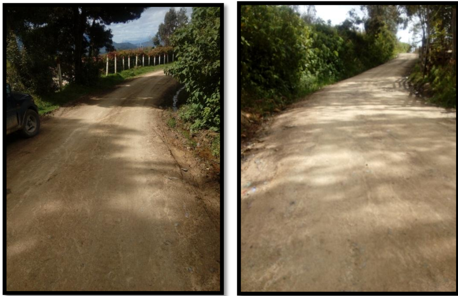
Fotografía 7. Carretera vereda Siuman-Ruche para construcción de placa huella.
