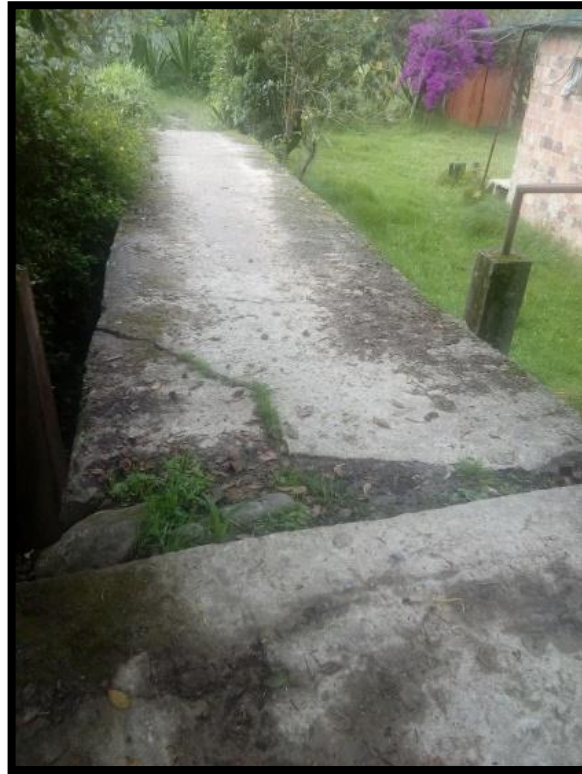
Fotografía 3. Acceso Vehicular puente Portachuelo
