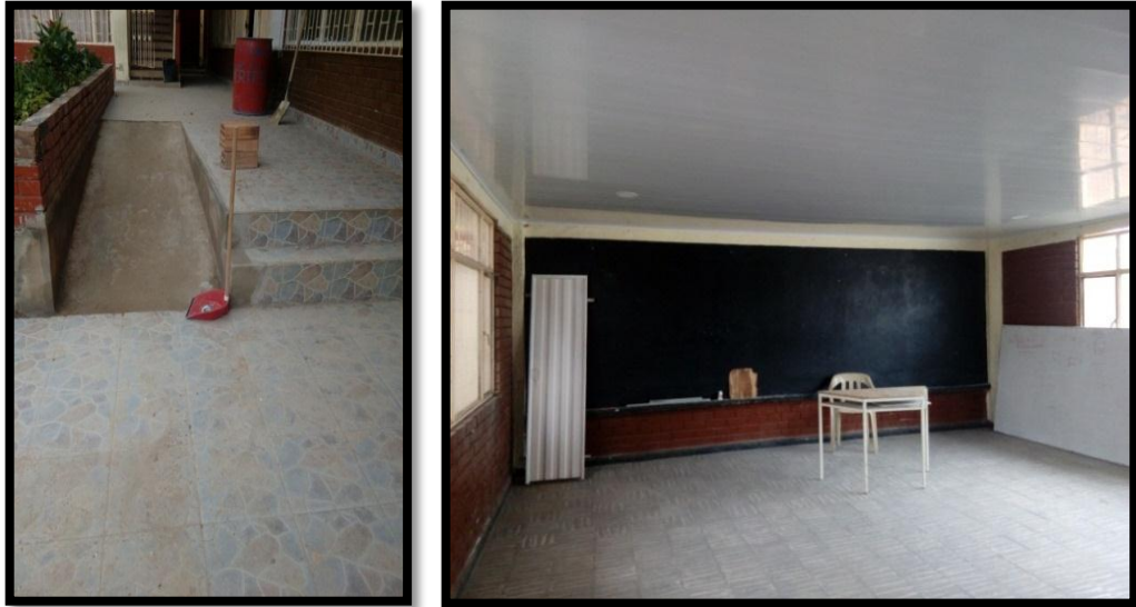
Fotografía 13. Arreglo de salones escuela La Esperanza
