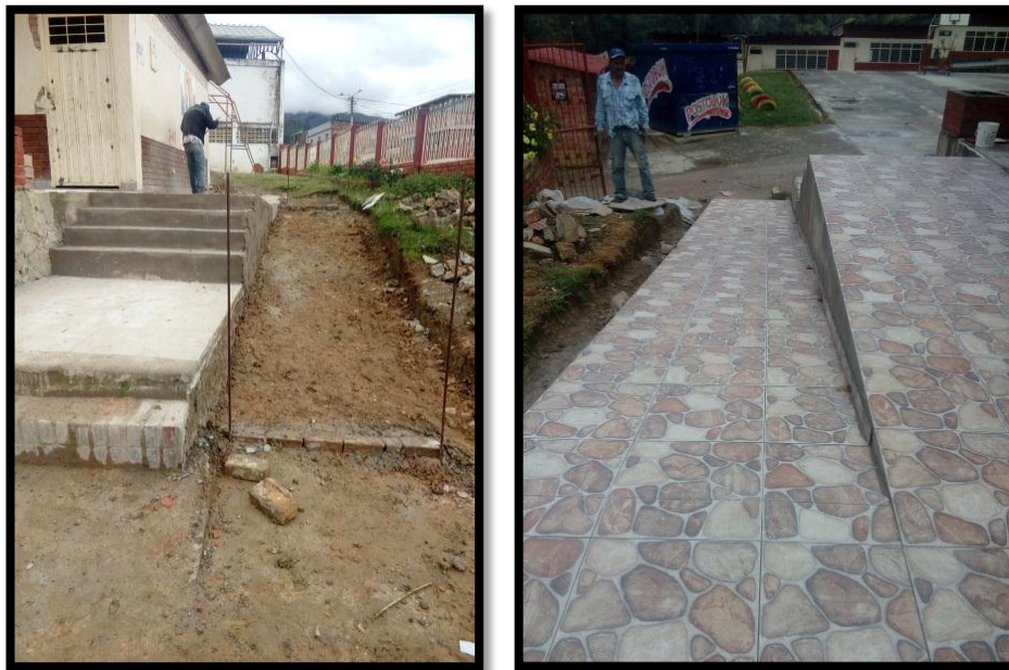
Fotografía 12. Construcción de Rampas Escuela La Esperanza
