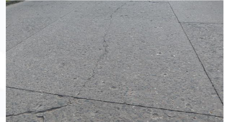
Ilustración 2. Grieta Longitudinal
