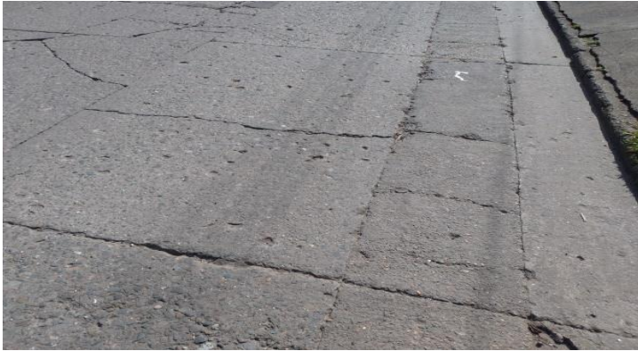
Ilustración 1. Grieta Transversal
