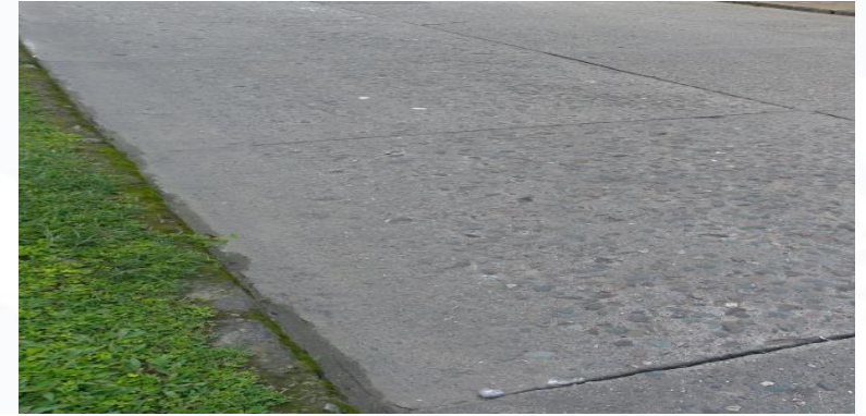
Ilustración 10. Pulimiento
