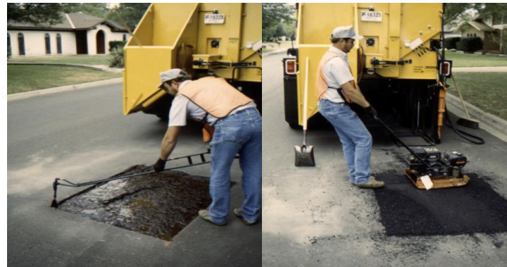
Imagen 7. Técnica de mejoramiento de parcheo
