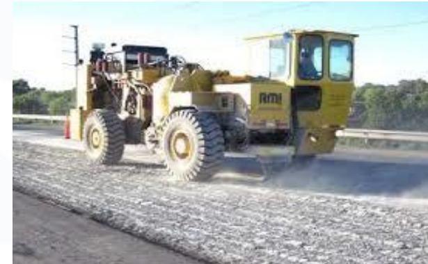
Imagen 6. Técnica de mejoramiento Rubblizing
