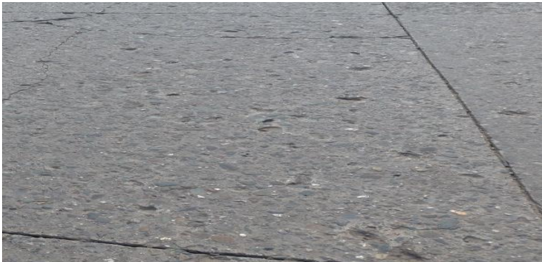
Ilustración 11. Desintegración
