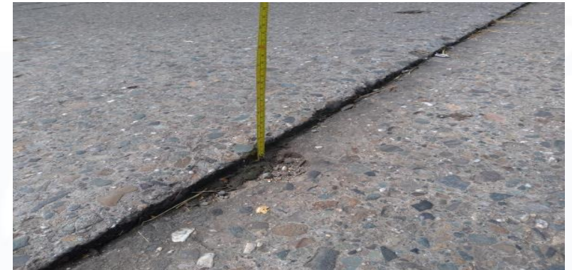
Ilustración 12. Hundimiento
