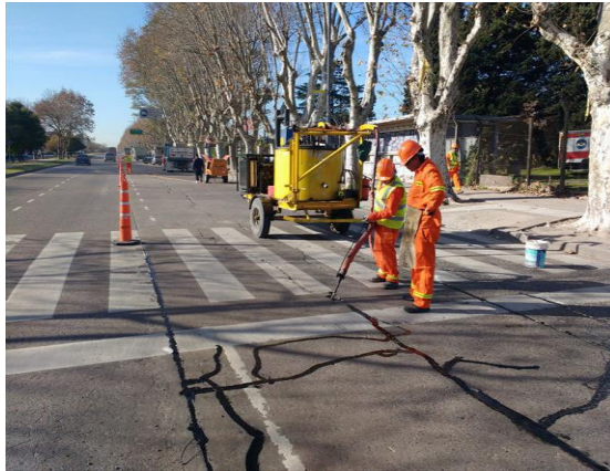
Imagen 5. Sello de fisuras y grietas
