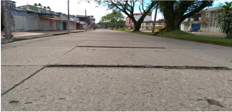
Ilustración 9. Escalonamiento de Juntas
