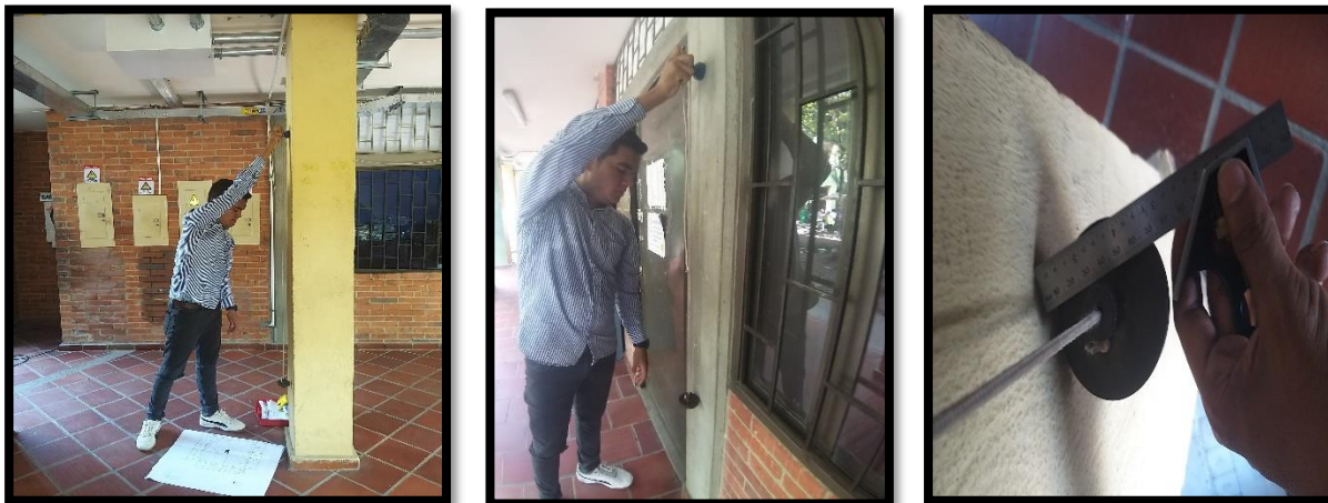
Ilustración 74 proceso de plomadas en columnas
