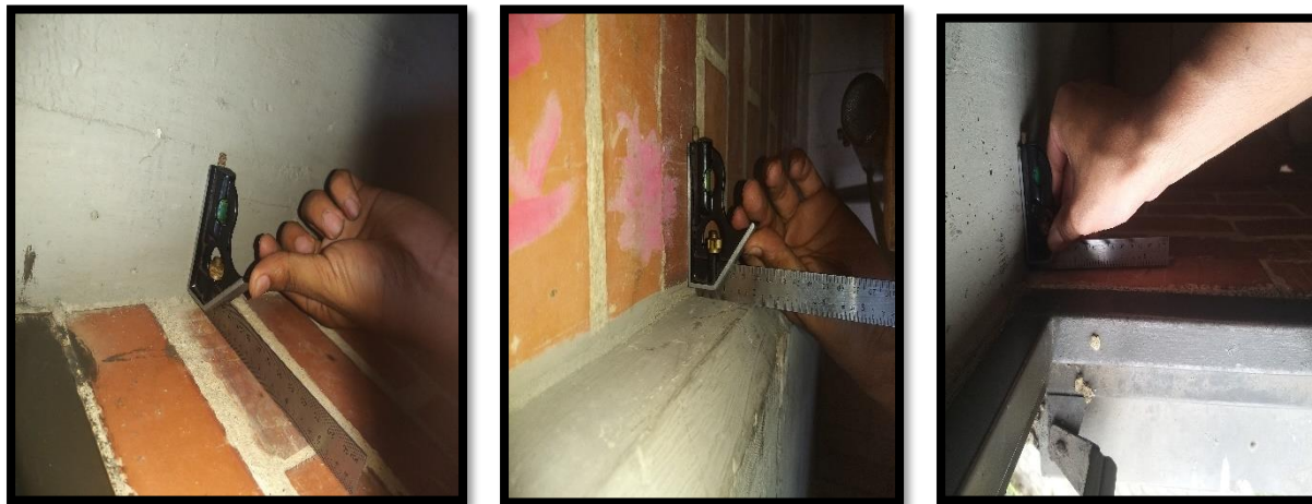
Ilustración 75 proceso de escuadras en muros
