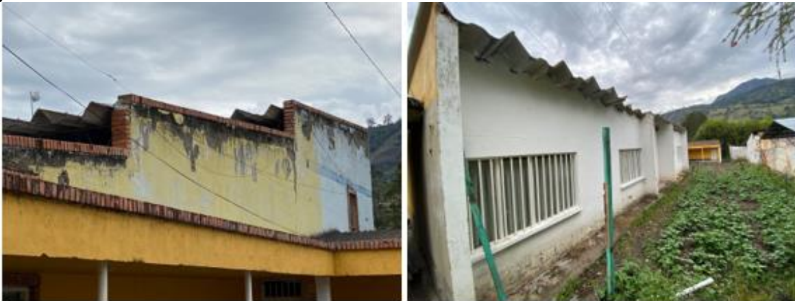
Figura 3. Condiciones de las instalaciones.
