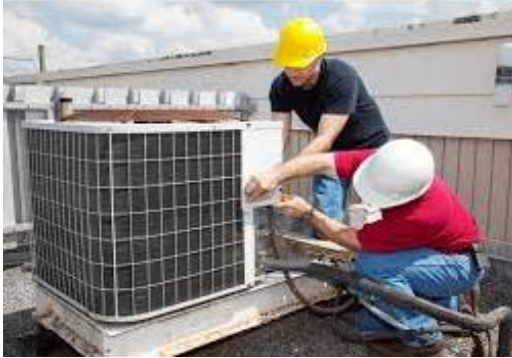
Figura. 10 Instalación de equipos y protocolos de prueba.
