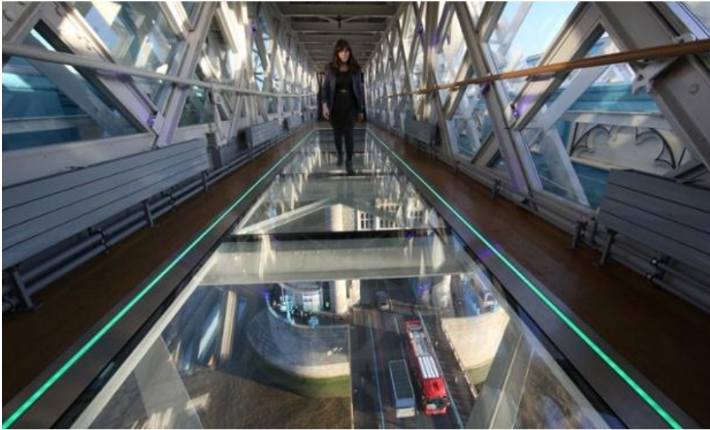
Imagen 34 Puente en paneles de vidrio, Londres, Inglaterra
