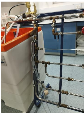
Figura 3. Conexión del instrumento de medición en las tuberías y accesorios.
