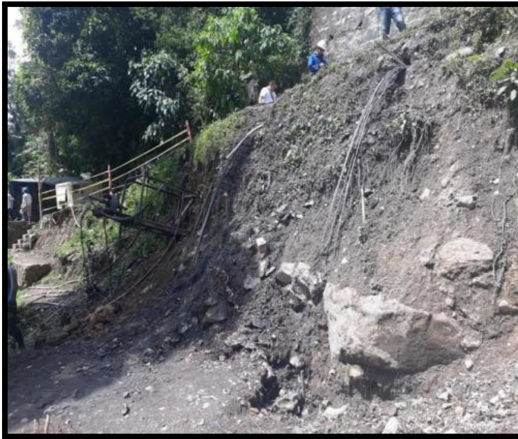
Fotografía 17. Anclajes activos instalados para la estabilización del talud y posterior construcción de caissons para mejorar la estructura de caissons para mejorar la estructura.
