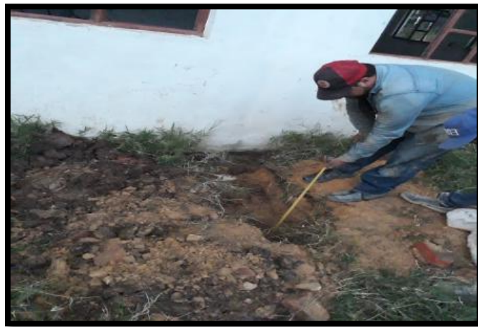
Fotografía 4. Excavación de calicata para determinar la conformación y la profundidad de los cimientos de la estructura.
