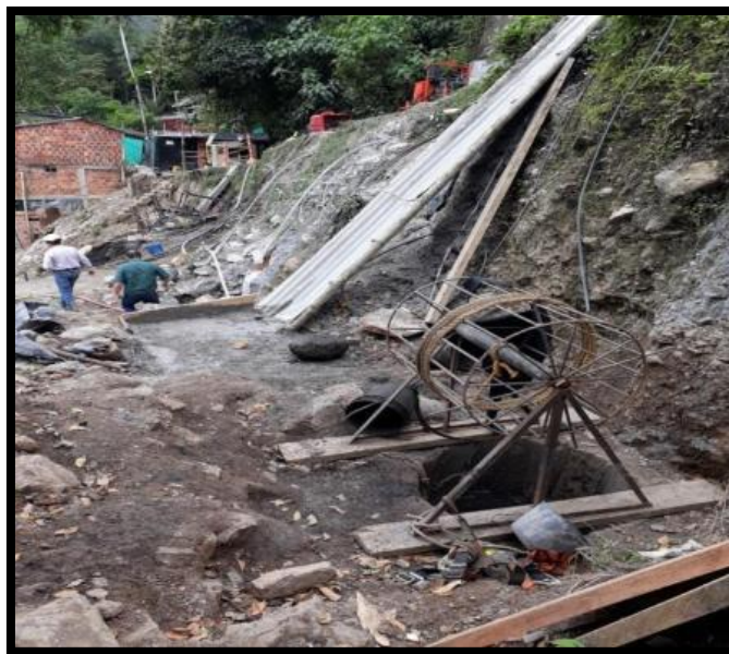
Fotografía 18. Elaboración de Caisson para estabilización de talud.
