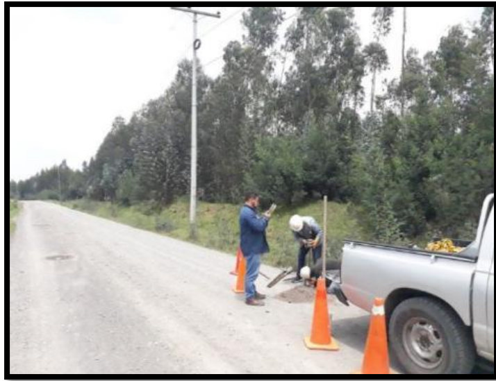
Fotografía 5. Excavación de apique en primer tramo de vía en Susa, con el cono dinámico para obtener el CBR de campo de suelos inalterados o que hayan sido previamente compactados.
