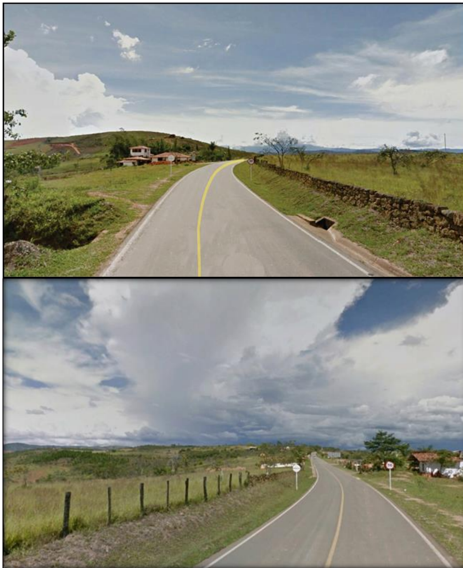
Figura 27. Estado actual de la carretera San Gil – Villanueva. tomado Fotografía propia.
