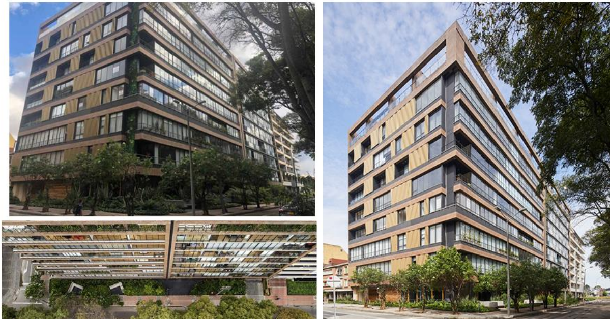
Figura 8 Fotos edificio Kubik Virrey
